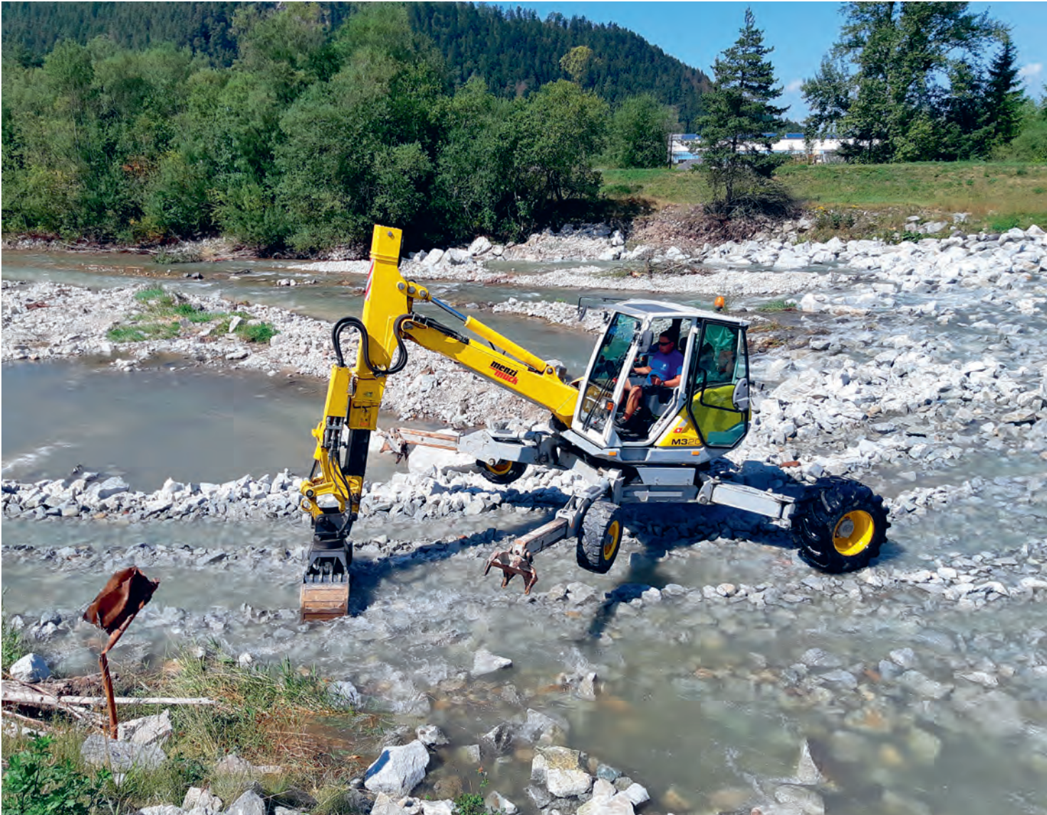
Liptovský Hrádok – oprava prahu na zaústení rieky Belá
