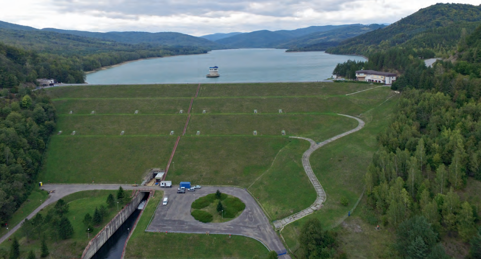
Podľad na sypanú zemnu hrádzu vodárenskej nádrže Starina
