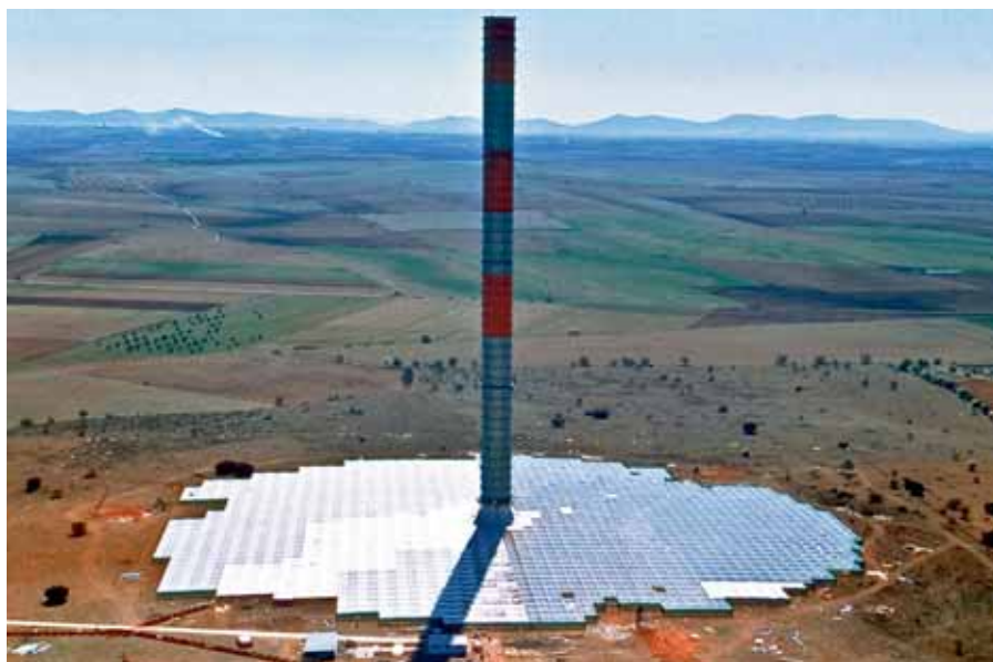
Obrázok č. 3: Pilotný projekt „Solar Chimney“ v Manzanares, Španielsko počas prevádzky v roku 1982
