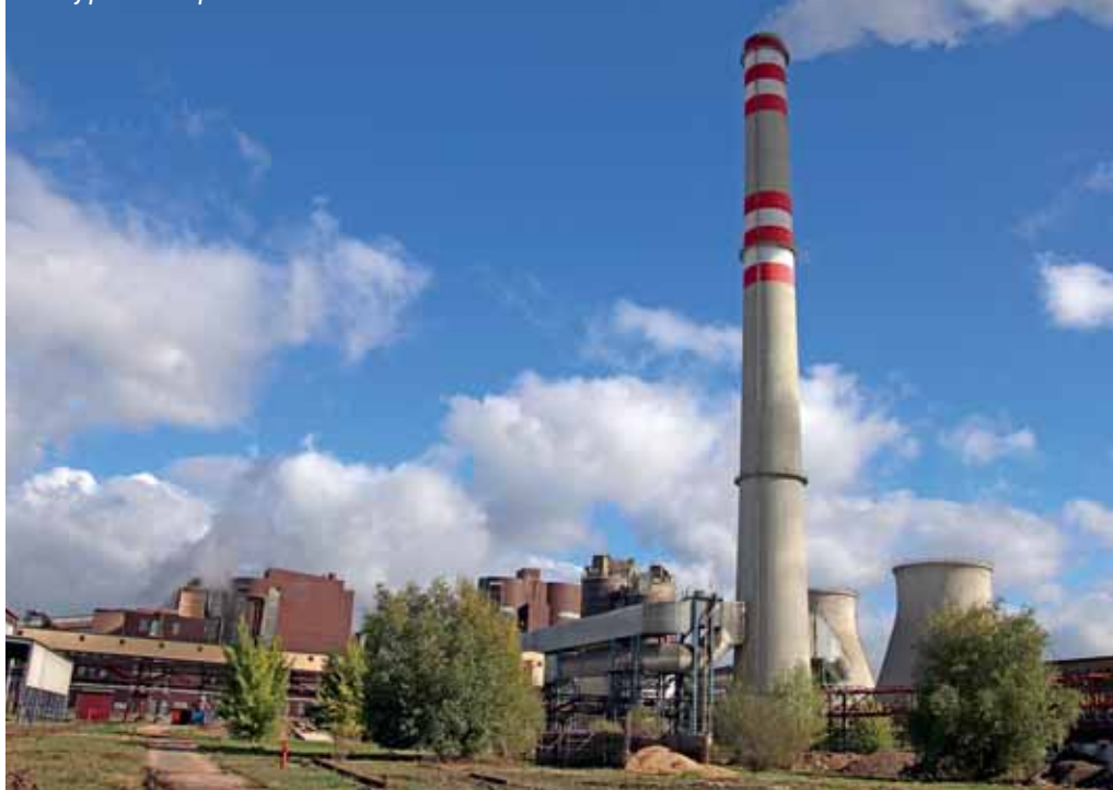
Celkový pohled na teplárnu T700
