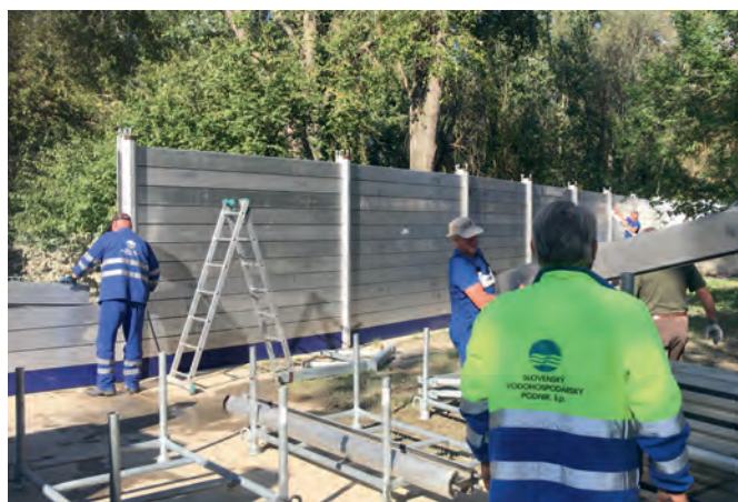
Inštalácia mobilného hradenia na Dunaji v Devíne počas povodňovej situácie
