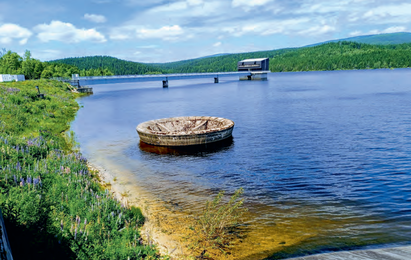
Obr. č. 4 Vodná nádrž Josefův Důl
