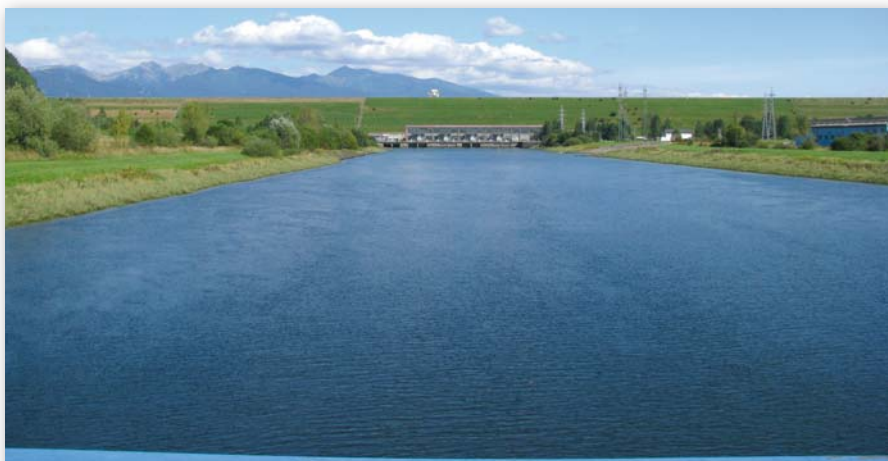
Liptovská Mara – čelný pohľad z odpadového kanála na priehradnú hrádzu.
