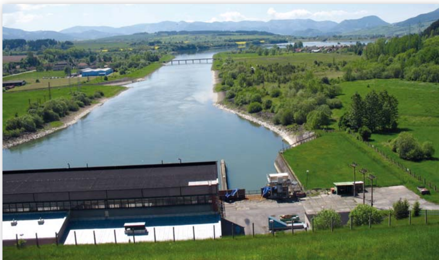
Pohľad z hrádzu na elektrárňu a odpadový kanál. V pozadí vyrovnávací vodná nádrž Bešeňová.
