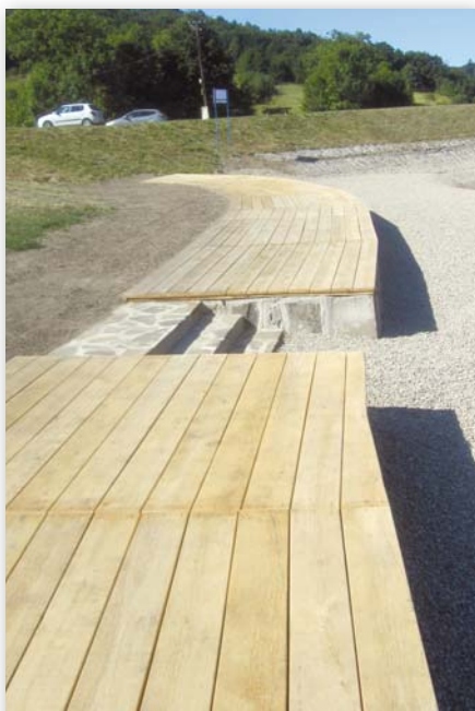
Priestor na odpočinok a opaľovanie, ktorý je pokrytý ohobľovanými, vode a poveternostným podmienkam dobre odolnými dubovými doskami prekrýva oporný múr na rozlohu viac ako 100 metrov štvorcových.
