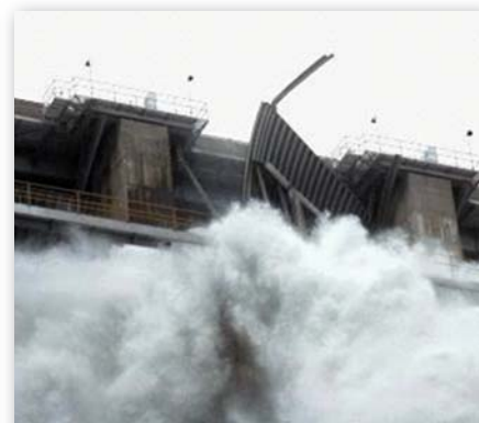
Obr. 2 Porušení hrazeného přelivu na přehradě Folsom v roce 1995 [16].
