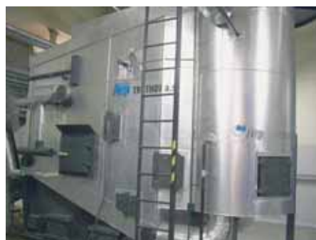
Obrázek č. 3: Kotel na slámu 800 kW
