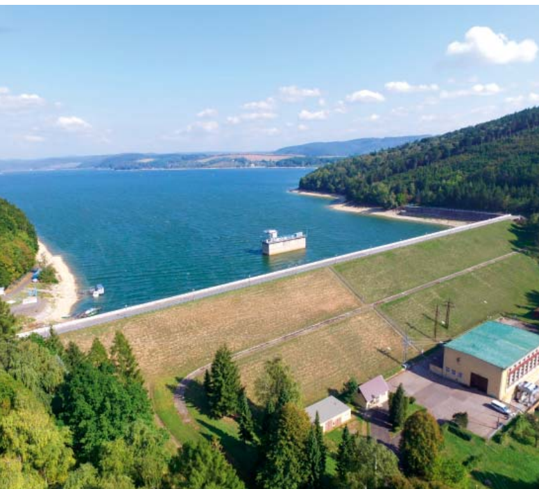
Vodná stavba Veľká Domaša
