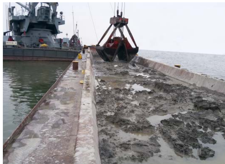
Obr. 6 Ťažba sedimentov [6] a vykladanie za Muchovú hrádzu, 2018 [6]
