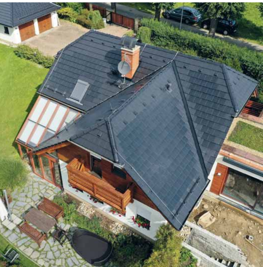
Obrázek č. 5: Pohled na dům v Jeseníku se solárními střešními taškami
