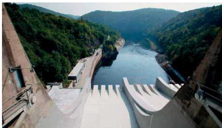
Přehradní nádrž a elektrárna Slapy
