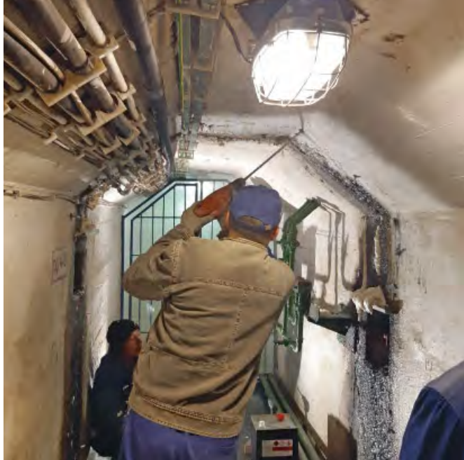
Injektážne práce, realizované vlastnými zamestnancami na zamedzenie priesakov cez dilatáciu v spojovej chodbe VS L. Mara, 2023
