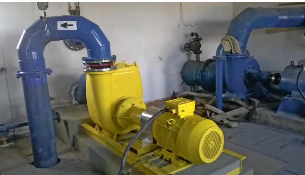
Generálna oprava čerpadla L. Trnovec a Vlašky
