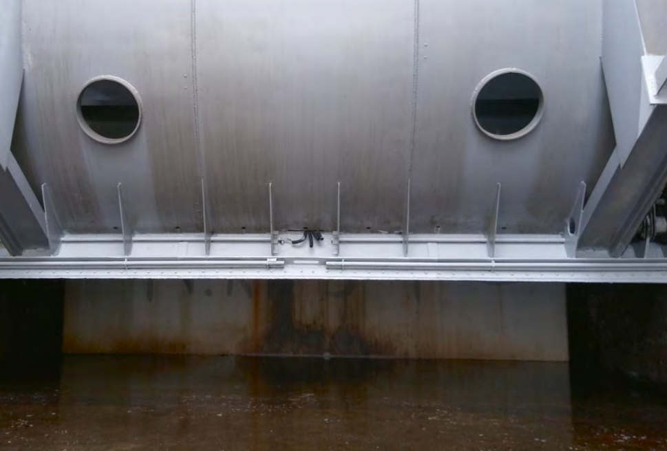
Čistenie a náter segmentov na VS Bešeňová, 2019
