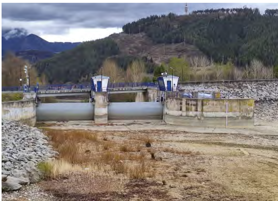
Oprava betónov bezpečnostného prepadu VS L. Mara, 2025
