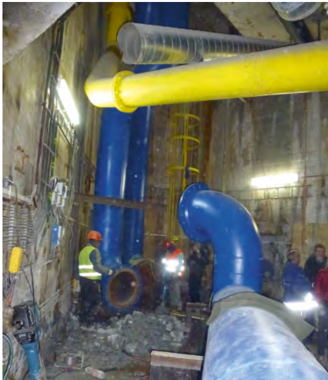
Stavebné práce v strojovni
