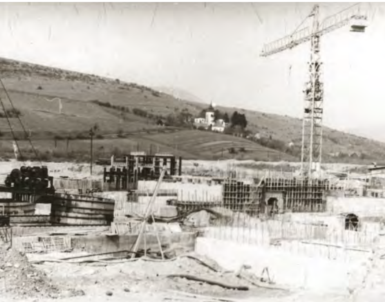
Proces výstavby injekčnej chodby v pozadí s ešte nezburaným gotickým kostolom Panny Márie z 13. storočia
