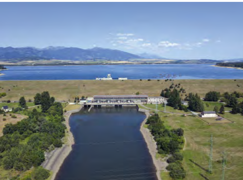
Pohľad na vzdušnú stenu hrádze Lipovskej Mary
