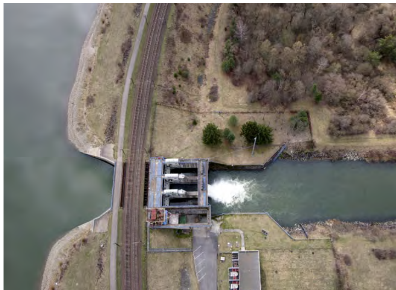
Pohľad na vodnú elektrárňu Bešeňová
