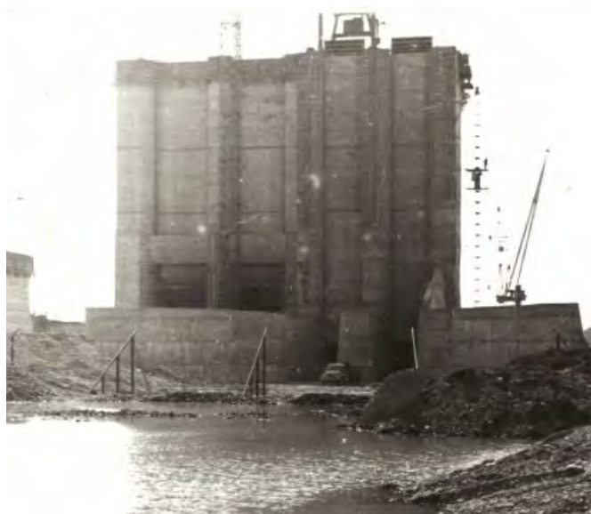
Výstavba vtokovej veže č. 1, Váh v pôvodnom koryte
