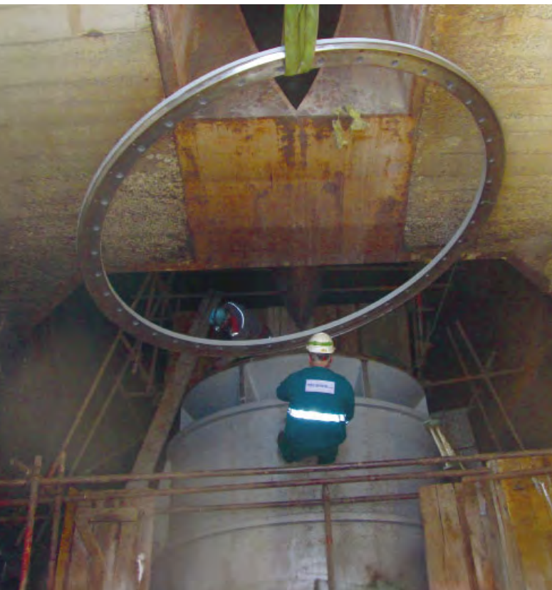
Oprava rozstrekovacieho ventilu, 2018
