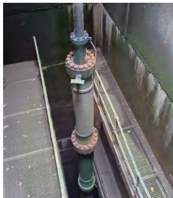
Oprava hydrauliky dnovej výpuste VS L. Mara, 2025
