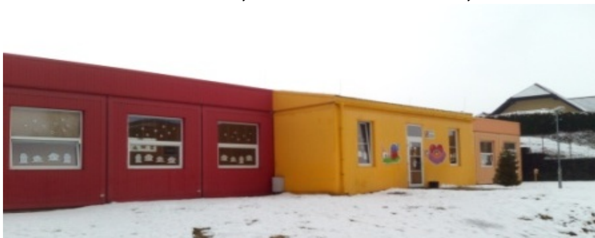
Obrázek 2: Pavilon MŠ Rychnov u Jablonce n. N. – modulární výstavba
