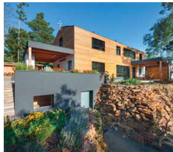
Pilotním projektem „Energetického konceptu FENIX“ v praxi je Rodinný dům v Omicích u Brna. Projekt zastřešuje UCEEB při ČVUT v Praze. Zdroj: FENIX
