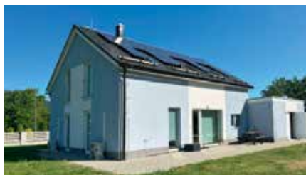
Rodinný dům je vybaven FV panely na střeše domu a garáží
