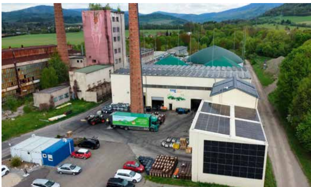
Instalace nových solárních panelů na rapotinské bioplynce
