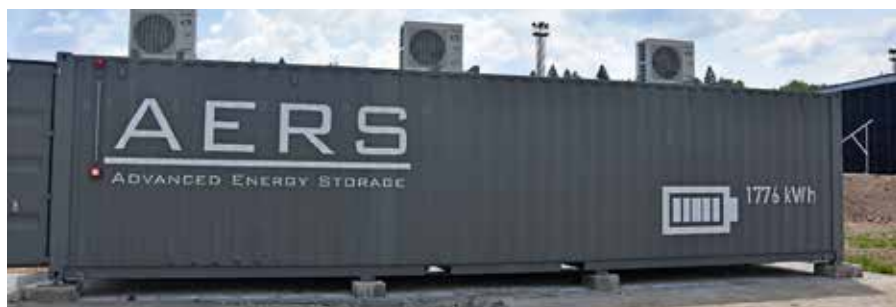
v areálu firma dostavěla další velkou fotovoltaickou a větrnou elektrárnu a rozšířila i kapacitu stávajícího bateriového úložiště. V současnosti tak má zdejší fotovoltaická a větrná elektrárna výkon 0,90 MWp. V Jeseníku současně vyrostlo největší bateriové úložiště v České republice s kapacitou 2,95 MWh a výkonem 4 \times 345 kW (1 380 kW). Úložiště slouží výrobnímu závodu pro snížení rezervovaného výkonu (rozložení spotřeby do 24 hodin), řízení čtvrt hodinových maxim a jako účinná ochrana a energetická záloha proti výpadkům, které mohou způsobit významné škody ve výrobě. Pomáhá také při řízení a kompenzaci kvality sítě a při maximalizaci využití energie z fotovoltaiky.
