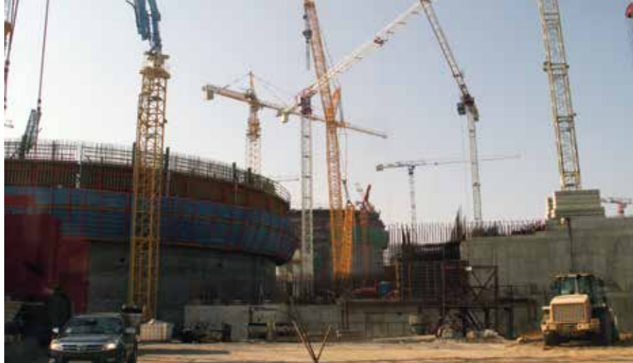
Obrázek č. 2: Pohled na dva rozestavěné reaktory jaderné elektrárny Leningrad II
