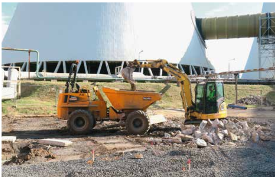
Buduje se základová deska nové plynové kotelny
