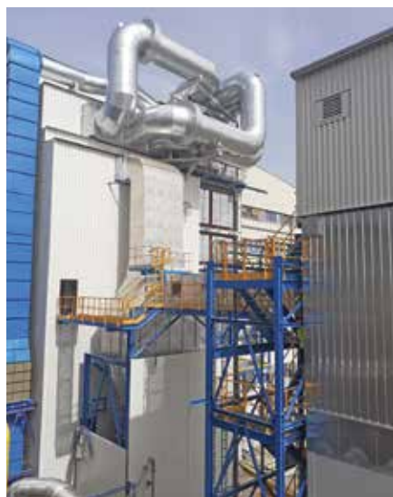
Budovaný kotel na biomasu umožní českobudějovické teplárně využívat k výrobě kromě jaderného tepla a v budoucnosti odpadu také dřevní štěpku
