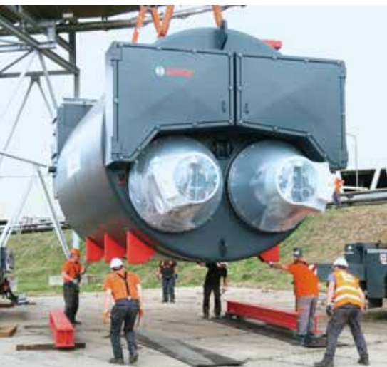
Při skládání kotle z podvalníku tahače šlo o přesnost na milimetry
