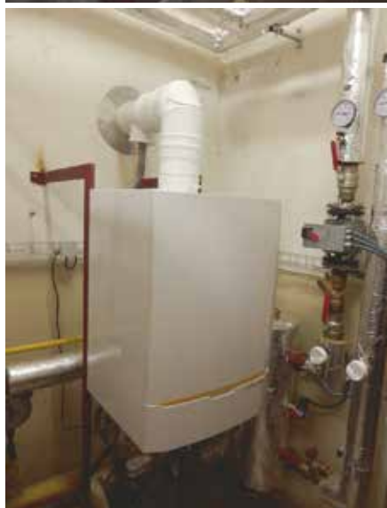
Obrázek č. 2: Holice, ZŠ Komenského 500 – plynová kotelná před a po realizaci
