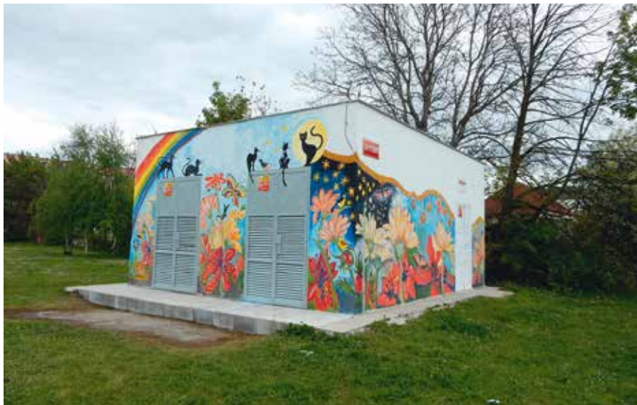
Obrázek č. 4: Domalování trafostanice v Písku, na kterém se podíleli senioři z Akademie třetího věku - květen 2017
