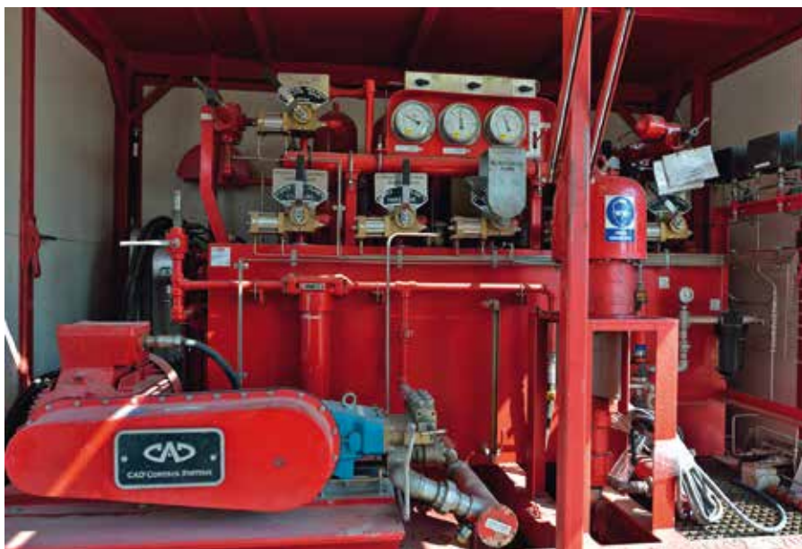
Motor vrtné soupravy se stejně jako celá vrtná souprava dá převážet z místa na místo na automobilu Tatra
