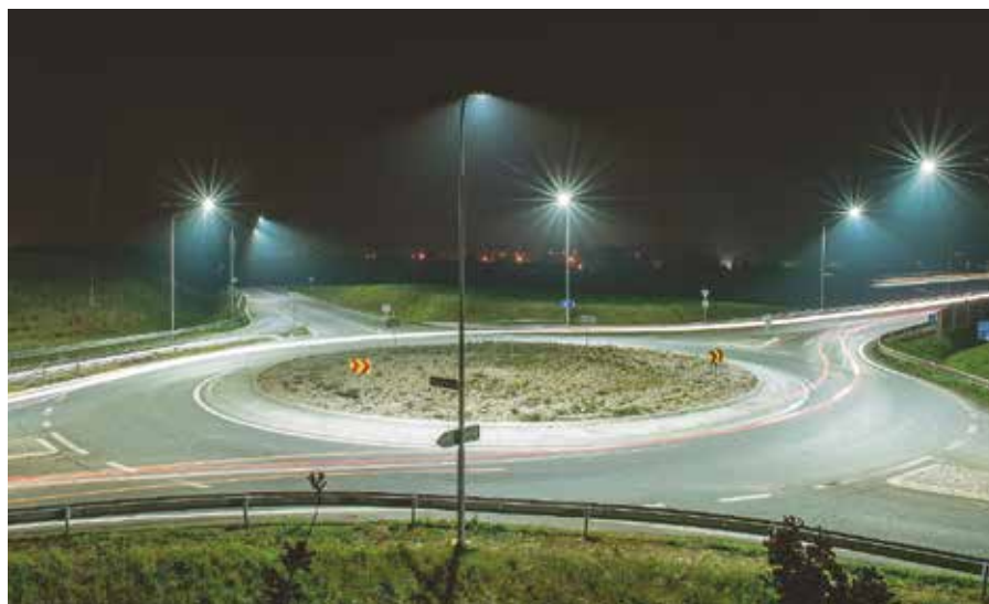
Obrázek č. 1: Realizace veřejného osvětlení na kruhovém objezdu v Holicích
