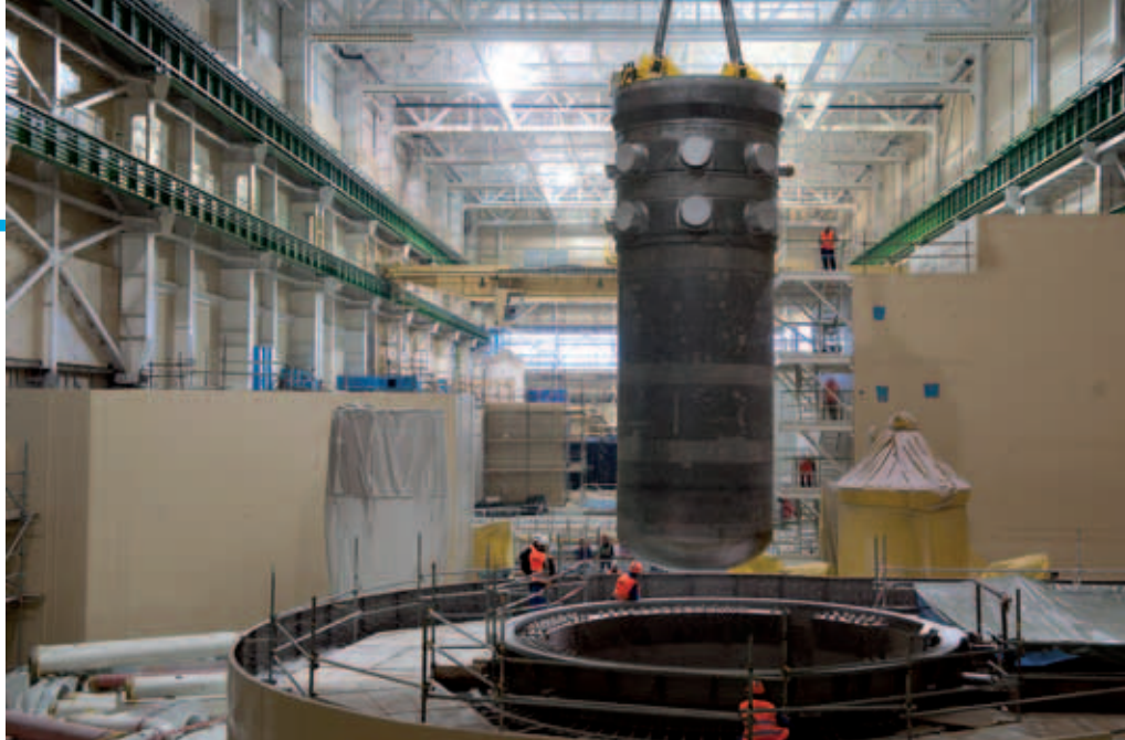
Obrázok č. 3: Tlaková nádoba reaktora stavaného 3. bloku AE Mochovce
