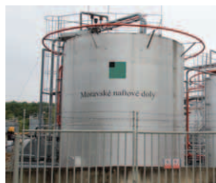
Obrázek č. 3: Zásobník ropy v Dambořicích
