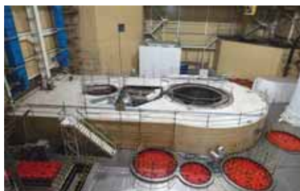
Postament reaktora 3. bloku Jadrovej elektrárne Mochovce
