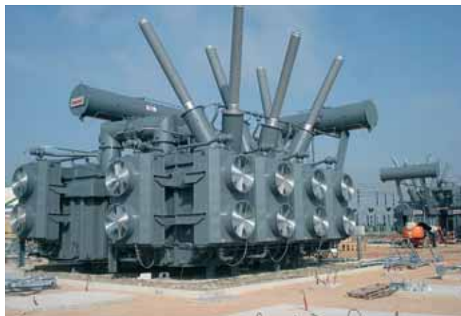
Obrázek č. 2: Ukázka podobného PST při montáži na stanovišti
