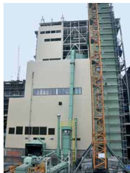
Obrázek č. 3: Výstavba fluidního kotle NK14
