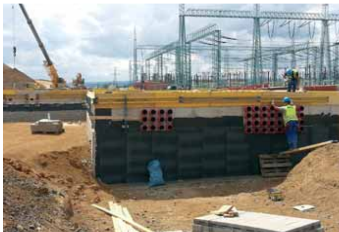
Obrázek č. 1: Výstavba centrálního domku
