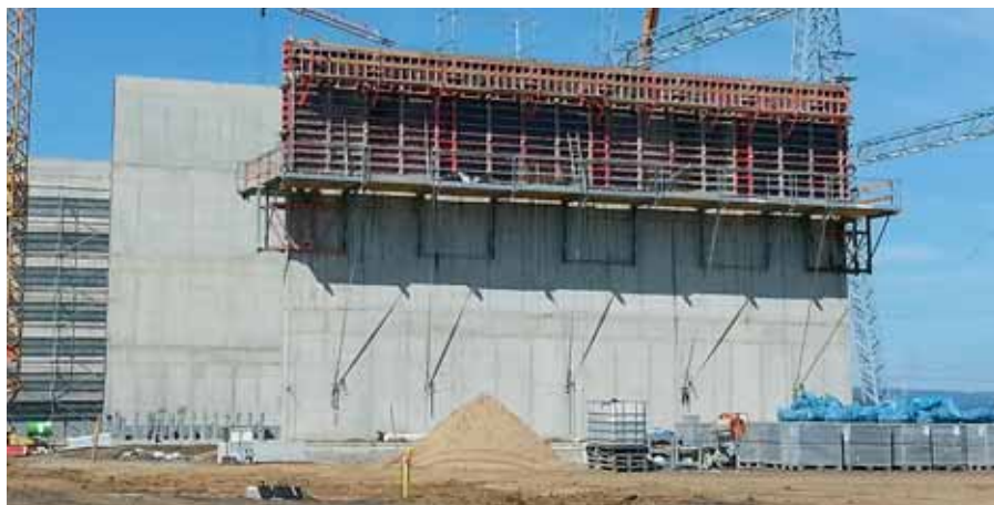
Obrázek č. 3: Výstavba stanovišť transformátorů PST
