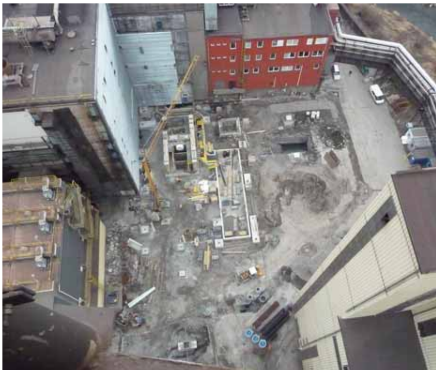
Obrázek č. 1: Pohled na staveniště v únoru 2014 – rozpracovaná spodní stavba NK14
