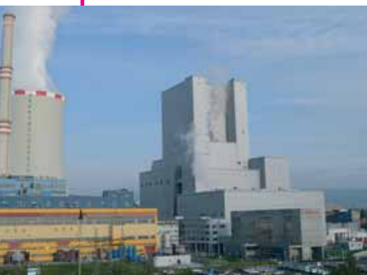
(Blíže o nové elektrárně v Ledvicích na str. 44)
