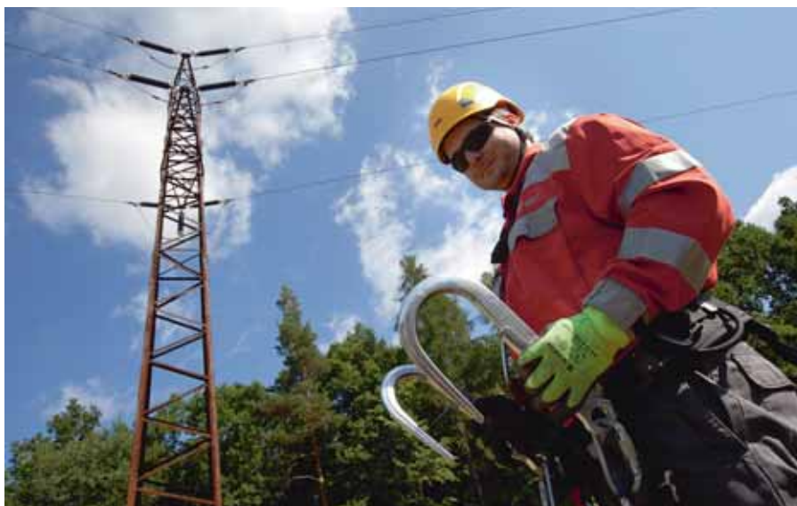
Obrázek č. 2: Jednoduchý nosný příhradový stožár pro 110 kV, pracovník E.ON s výstrojí pro lezeckou kontrolu
