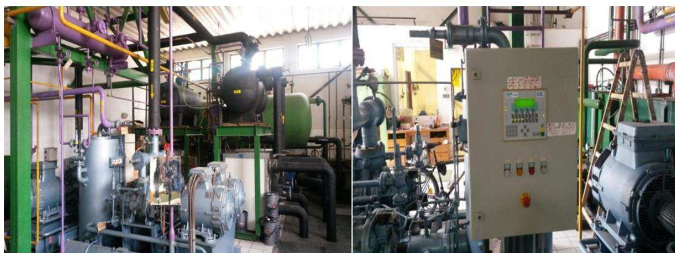
Obrázok 4 Strojovňa chladenia (kompresor, detektor NH 3 , tlakové nádoby) [4]
