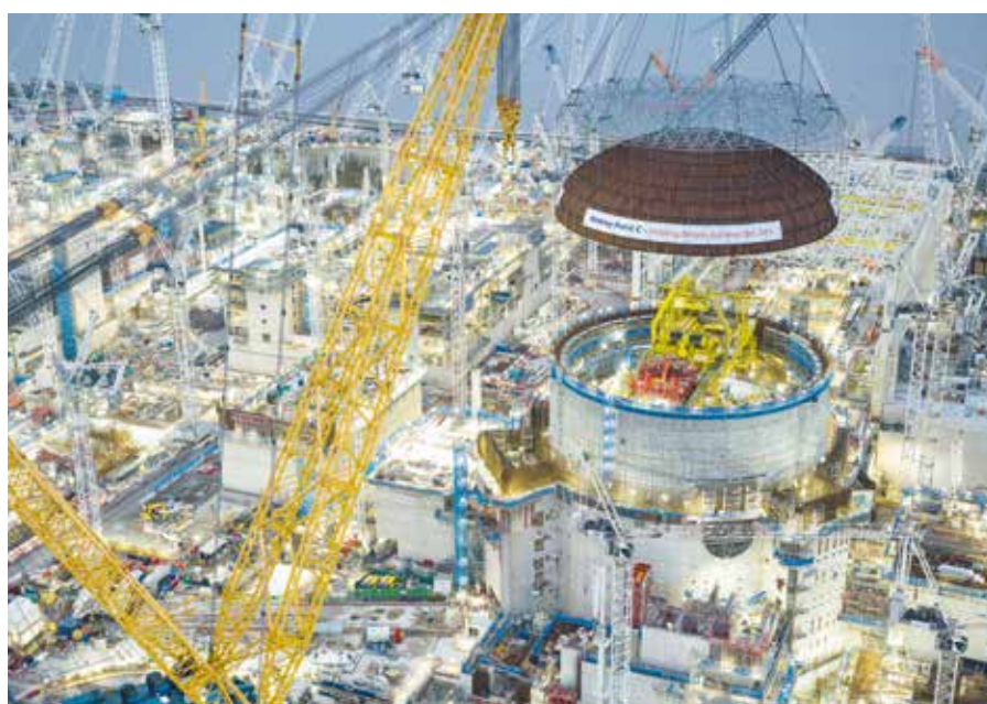
Jeřáb usazuje 245tunovou kopulovitou střechu na první budovu reaktoru v britském Hinkley Point C. Zdroj: EDF
