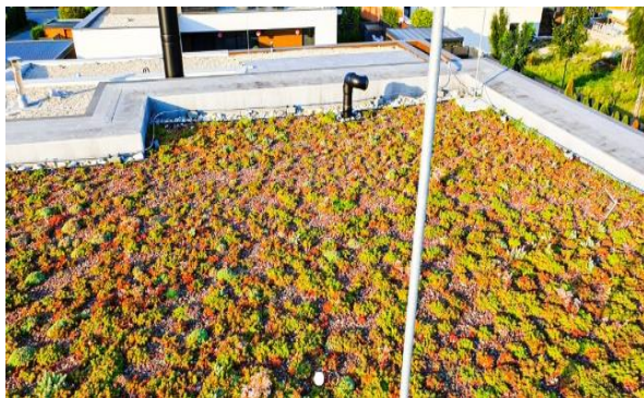
Vegetačná strecha s kvapkovou závlahou – Záhorská Bystrica
