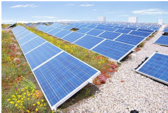
Vegetačná strecha s fotovoltaikou
