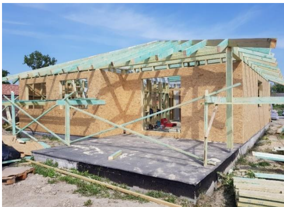
Obrázok 6: Konštrukcia hrubej stavby z KWH hranolov
