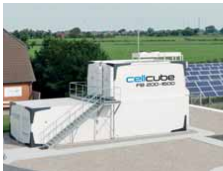
Obrázok č. 4: Vanad-Redoxová technológia akumulácie elektrickej energie FB 200-1600 o výkone 200 kW a kapacite 1 600 kWh
