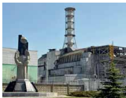
Obrázok č. 1: Jadrová elektrárňa Černobyľ ešte s pôvodným betónovým krytom
