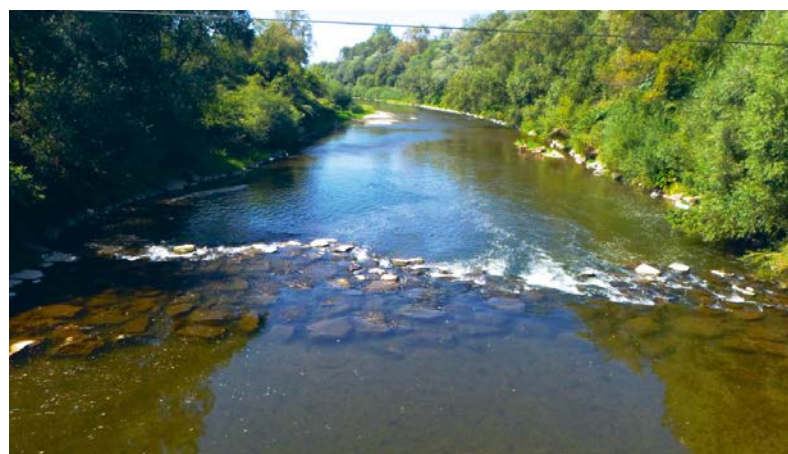
Obr. 9 Balvanitý sklz pri obci Špičky, pod ním v diaľke na ľavom brehu lavica
