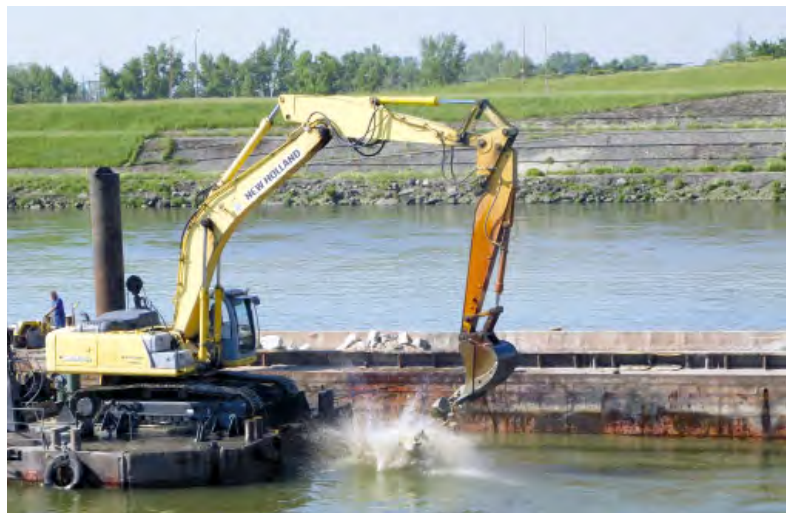
Obr. č. 6 Ukladanie lomového kameňa do výmolu č. 1
