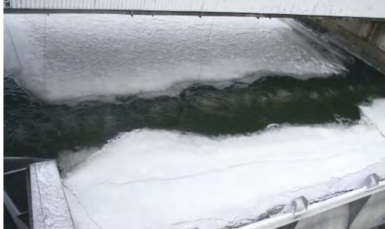
Obr. č. 12 Uvoľnenie tlaku ľadovej celiny na hradiace konštrukcie bublinkovou technológiou
