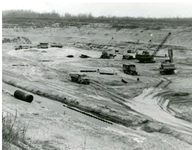
Obr. č. 2 Základová jama hydrouzla
