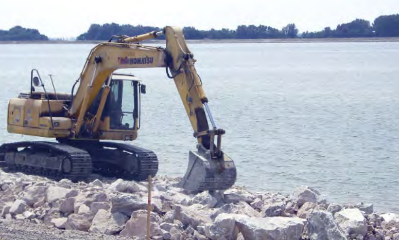
Obr. č. 11 Rekonštrukcia opevnenia PSH a LSH VS Kráľová
