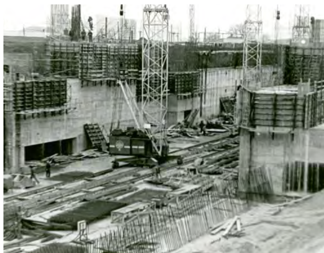
Obr. č. 3 Betonárske práce na hydrouzle
