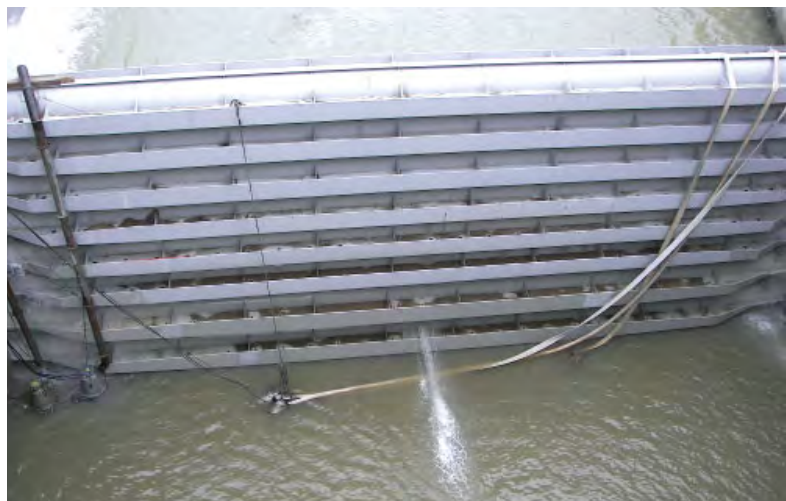
Obr. č. 7 Funkčná skúška provizórneho hradenia PLK
