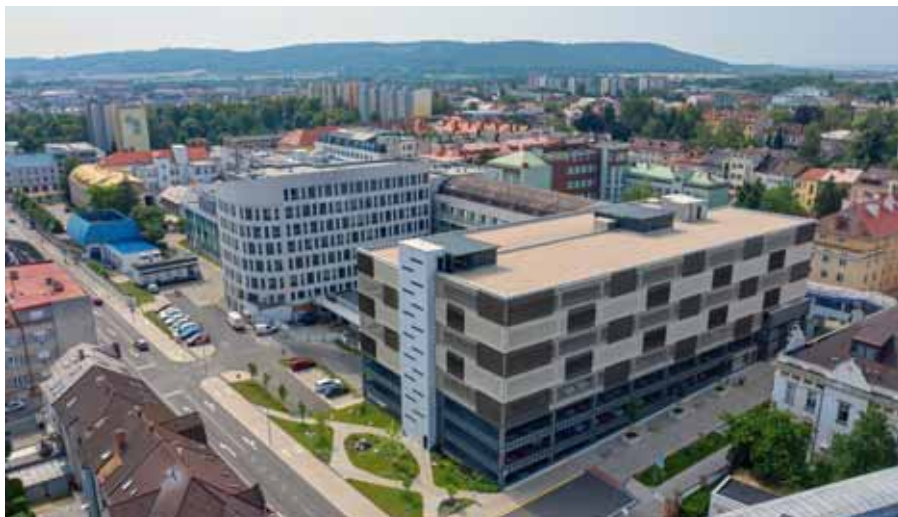
Mladoboleslavská nemocnice spouští velký projekt energetických úspor. Fotovoltaické panely a další řešení jí ušpoří 80 milionů korun.
