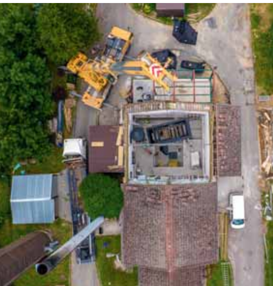
Biokotelna v Dešné u Dačic si po čtvrtstoletí provozu vyžádala výměnu původních ocelových rozvodů za plastové i technologie v kotelně.
