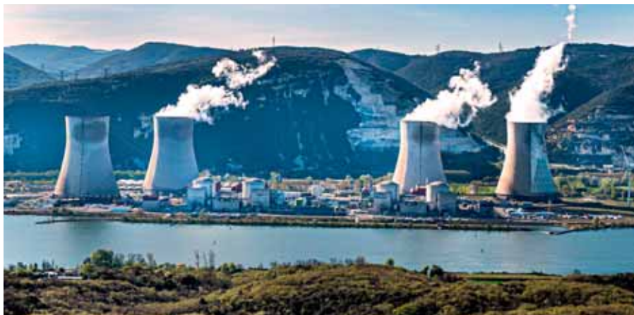
Voda řeky Rhône se používá k chlazení několika jaderných elektráren v jižní Francii, jako je tato v Cruas. Zdroj: EDF
