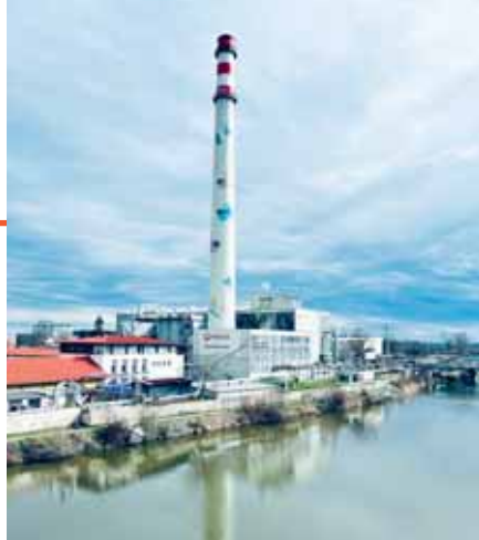
V Elektrárně Kolín byl hnědouhelný parní kotel přestavěn na kotel, který spaluje zbytkovou hmotu z těžby dřeva a rostlinné peletky.
