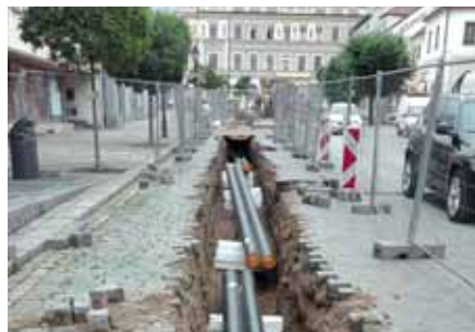
V letech 2017 až 2022 proběhla v Písku kompletní výměna téměř 12 kilometrů dosluhujících parovodních rozvodů efektivnějšími horkovody.
