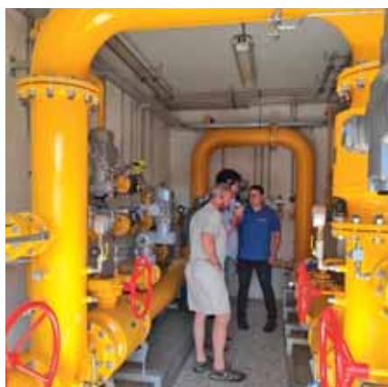
Exkurze po příkladech technologií pro komunitní energetiku v Bavorsku – vodíková stanice s 1 MW elektrolyzérem, Hassfurt
