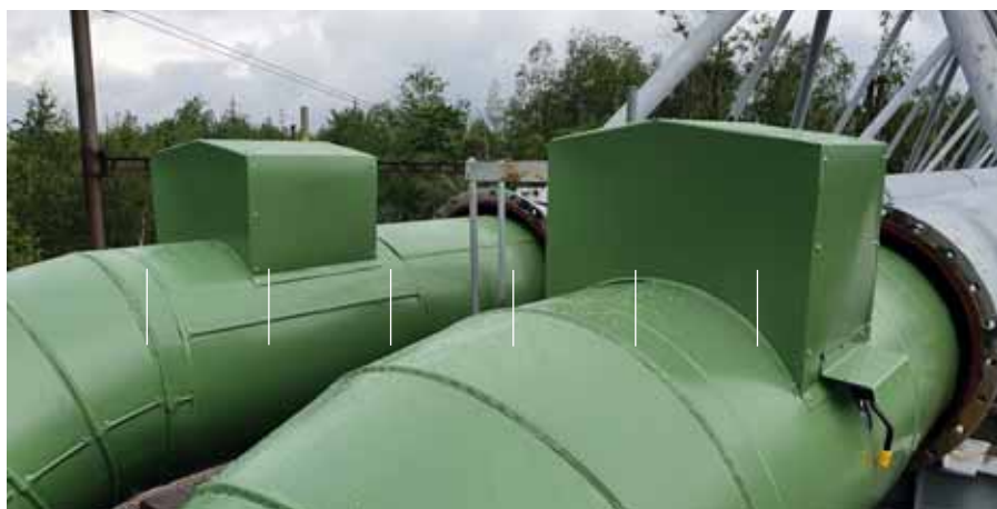
V rámci modernizace a zefektivnění dodávek tepla byla v letech 2020 až 2022 provedena rekonstrukce tepelného napáječe z teplárny společnosti United Energy z Komořan u Mostu do Litvínova.
