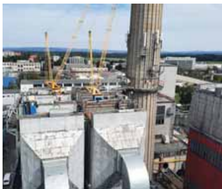
Rekonstrukce uhelných kotlů na 100% spalování biomasy se zajištěním skladování, třídění a sušení štěpky na zdroji společnosti C-Energy v Plané.
