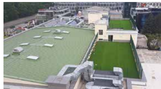
Pohled na střechu školy St. George School & Preschool. V popředí střecha strojovny, v níž jsou umístěna tepelná čerpadla.
