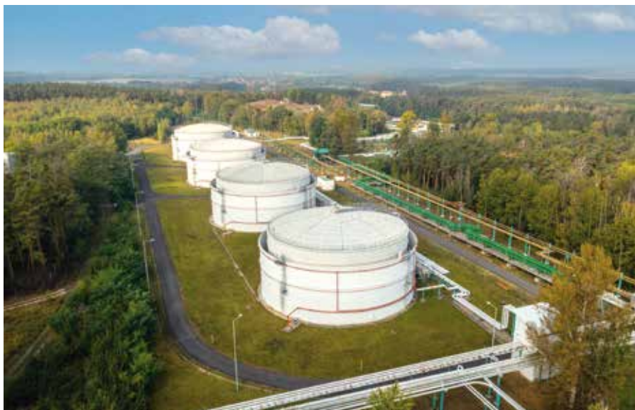
Velkokapacitní nádrže ve skladu v Hněvicích
