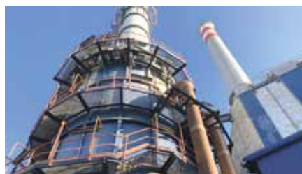
Intenzifikace stávající mokré vypírky spalin v Plzni zvýšila účinnost snižování emisí síry z 82,5 na 97,4 %.
