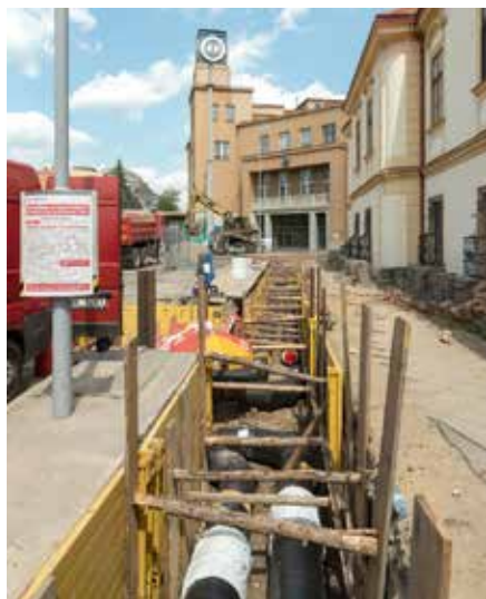
Teplárny Brno pokračují ve výměně zastaralých parovodů za modernější a efektivnější horkovodní rozvody.
