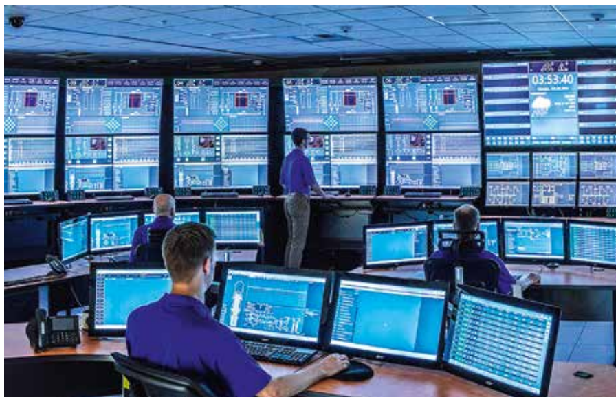
Elektrárna NuScale SMR má schválený projekt pro řízení provozu až 12 reaktorů z jediné místnosti.
