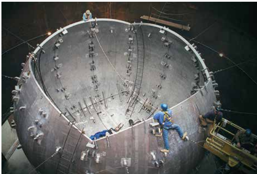
Historický záběr z budování desetimetrové reakční komory o hmotnosti 130 tun. Právě do ní se soustředí laserové paprsky a útočí na miniaturní kapsli velikosti zrnka písku.
