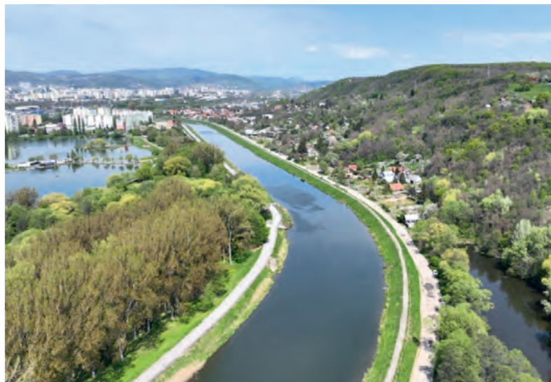
Košice – protipovodňová ochrana mesta – úprava ľavého brehu Hornádu v rkm: 29,900 – 31,550 – pred realizáciou
