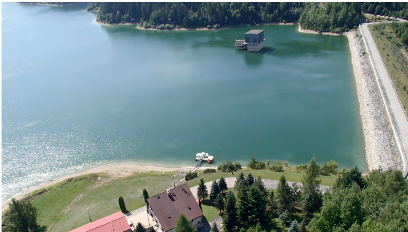
Obr. Č. 12 Vodárenská nádrž Nová Bystrica
