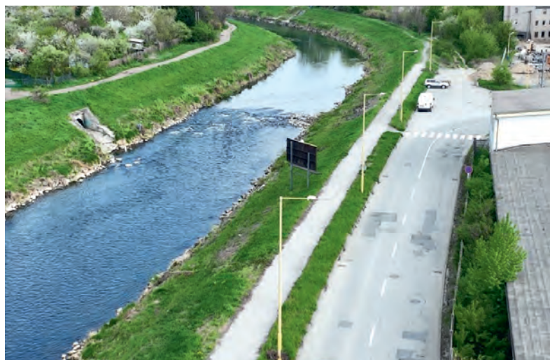
Košice – Prioritné protipovodňové opatrenia v SR, Hornád – ochrana intravilánu mesta, ľavý breh rkm: 140,644 – 141,911 – pred realizáciou
