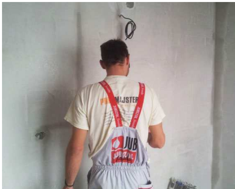
Obrázok č.2: Zamestnanec v priebehu rekonštrukčných prác Zdroj: http://www.profimistr.cz/uvod.html
