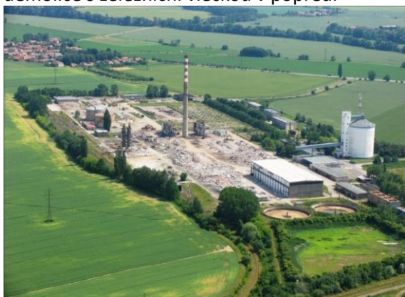
Obrázek 5: Letecký pohled na areál bývalého cukrovaru v Hrochově Týnci v průběhu demolice s železniční vlečkou v popředí
