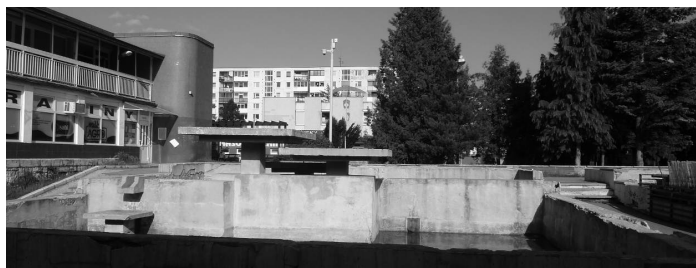
Obr. 4. Centrálna časť nákupného strediska Centrum – stav v máji 2013
