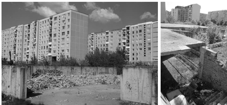
Obr. 12. Zdevastovaný areál krytu civilnej obrany na sídlisku Sekčov
