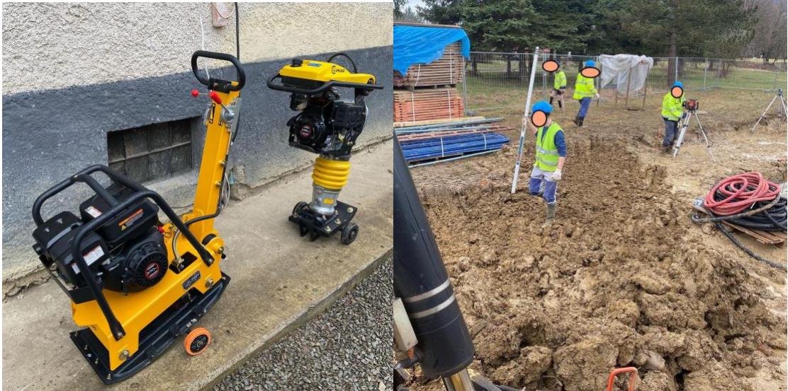
Obrázok 5 Hutniaca technika a rotačný laser
