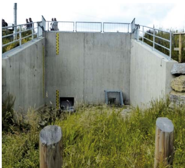
Obr. 5 Pohľad na prietokový a priechodový otvor poldra – vzdušná a návodná strana
