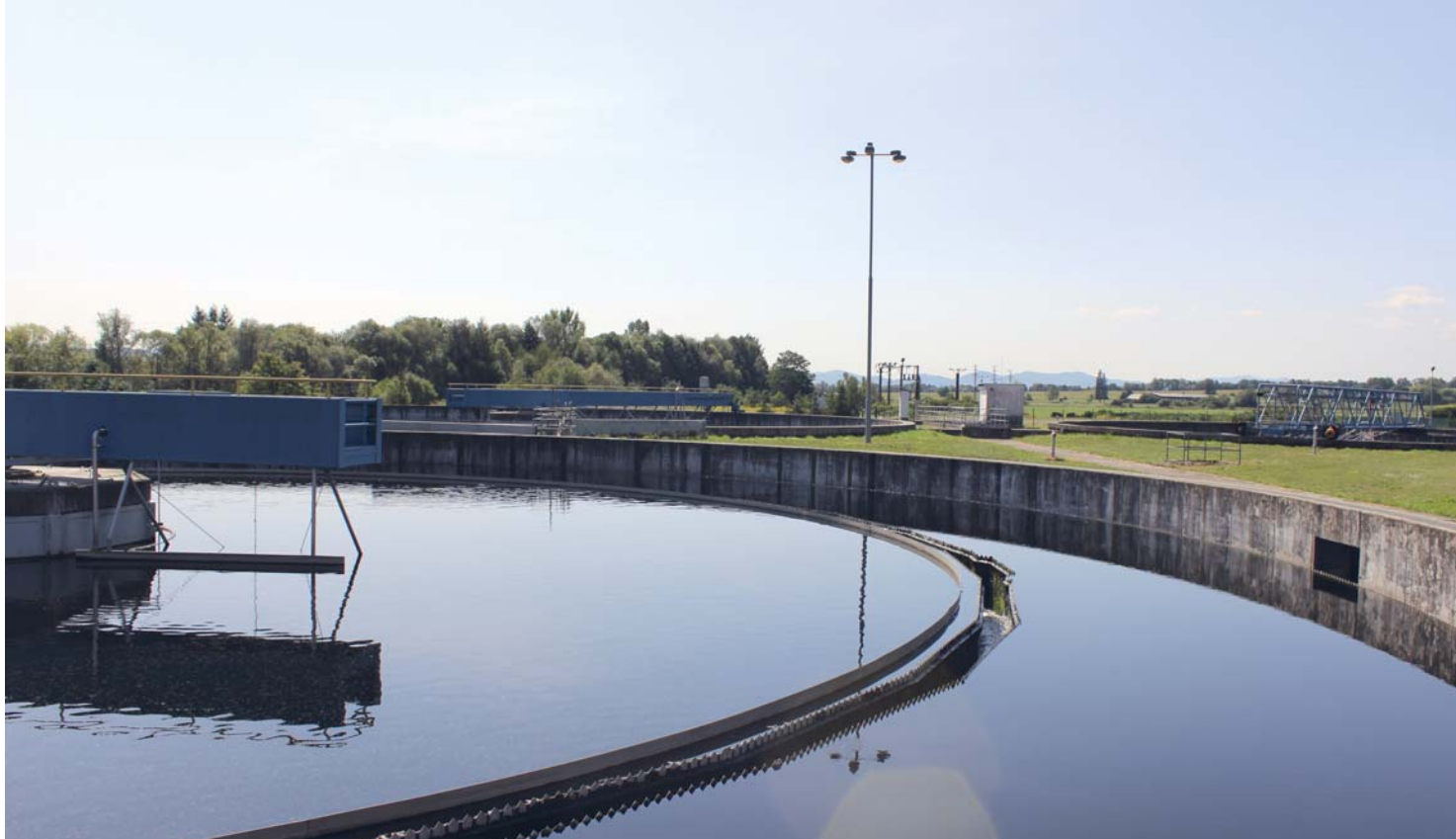
Dosadzovacia nádrž ČOV Banská Bystrica
