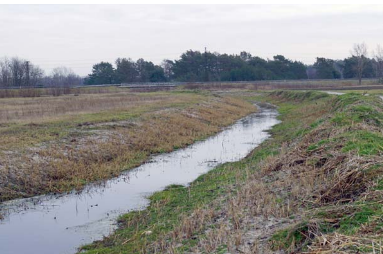
Revitalizované existujúce koryto Porca smerom k diaľnici
