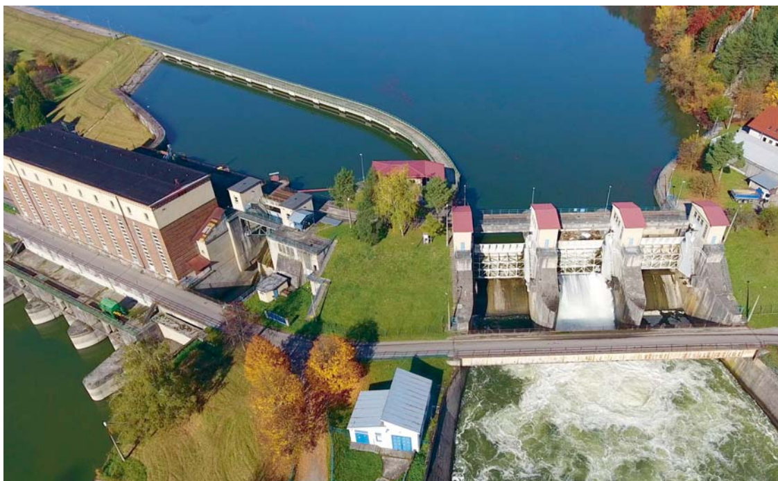
Vodná stavba Krpeľany
