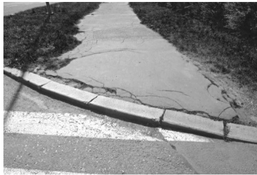
Obr. 1 Příklad pěší komunikace nesplňujícího požadavky na bezbariérové užívání.
