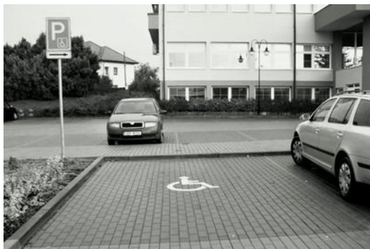
Obr. 5 Příklad opomenutí řešení bezbariérového přístupu z parkovacího stání na pěší komunikaci.
