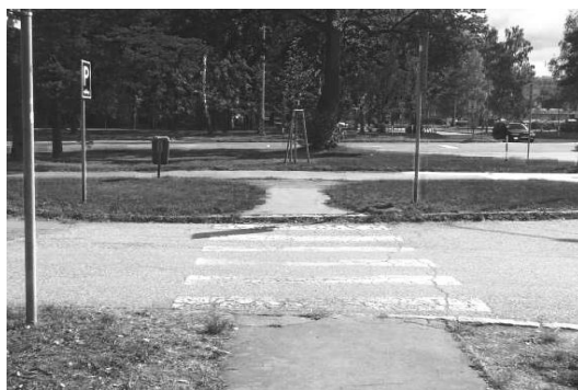
Obr. 3 Příklad přechodu pro chodce s absencí vodících linií a nevhovujícím výškovým rozdílem.
