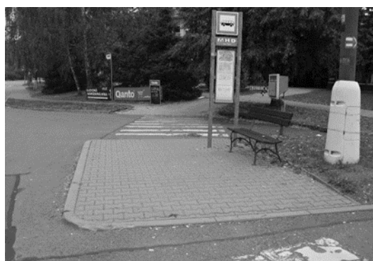
Obr. 4 Nástupiště zastávky MHD s absencí jakýchkoli vodících linií pro zrakově postižené a výškovým rozdílem menším než 200mm oproti vozovce znemožňujícím bezbariérový nástup/výstup osob na vozíku do dopravního prostředku.
