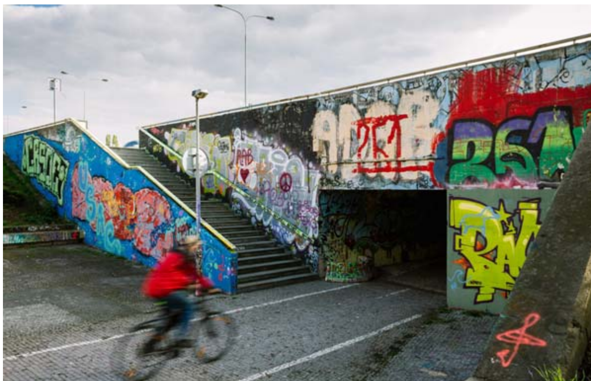
Podchod v Braníku u zastávky Pobřežní cesta. Zdroj: IPR
