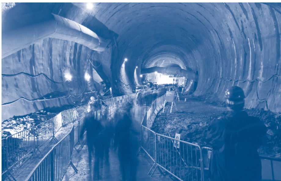
Pohled do rozestavěného tunelu Blanka.
