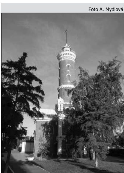
Historická požiarňa zbrojnica
