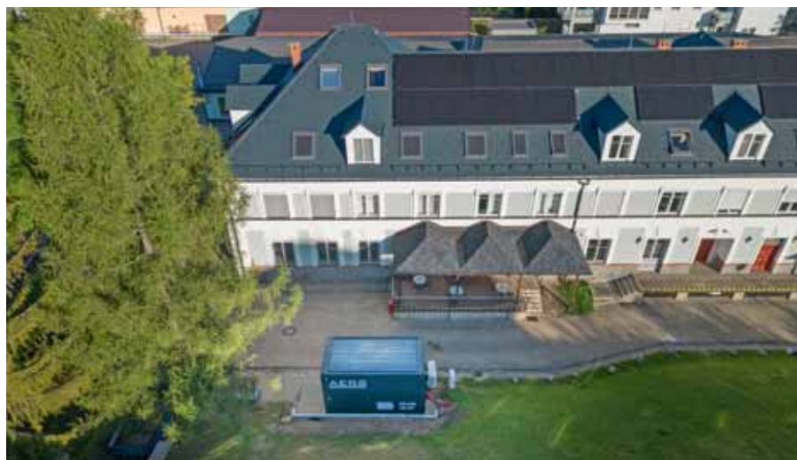
Polyfunkční dům na ulici Slezská v Jeseníku s bateriovou stanicí MES
