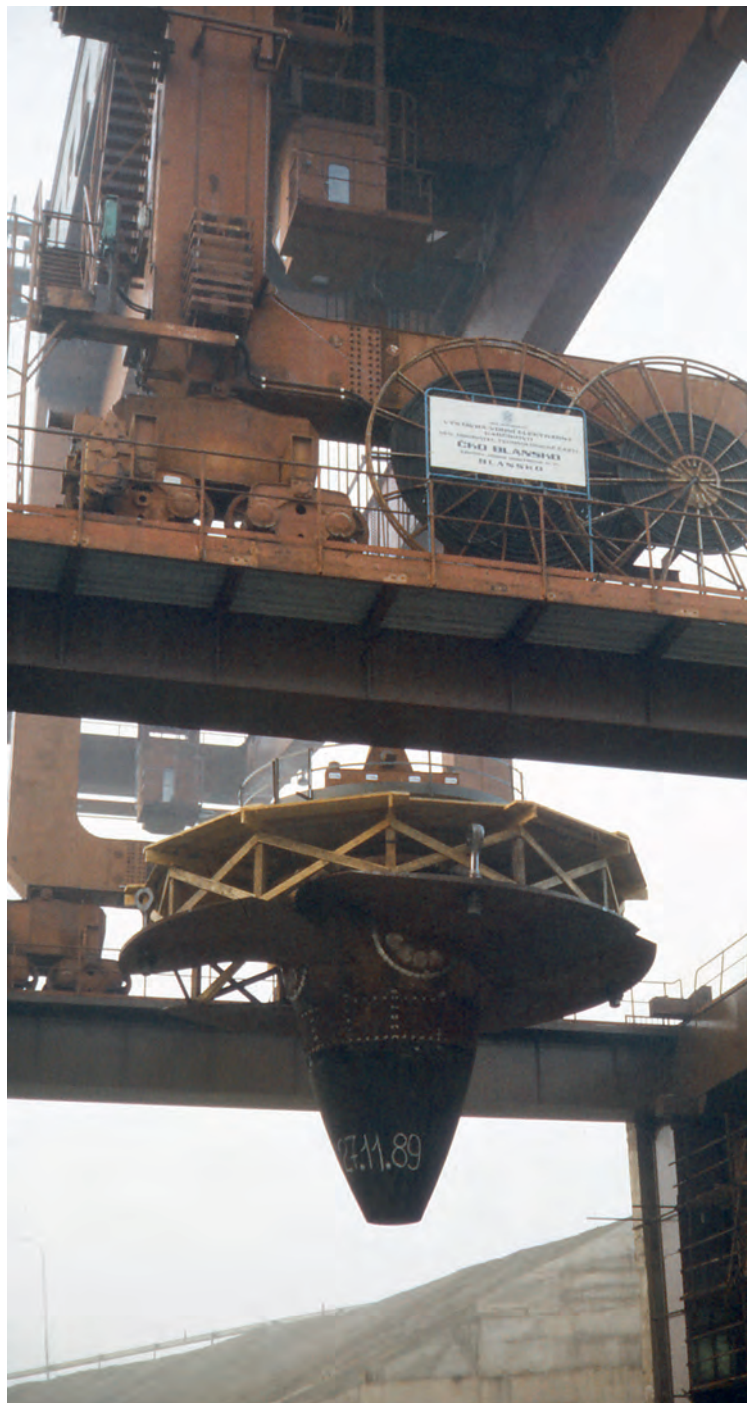
Prevoz turbín pri výstavbe VE
