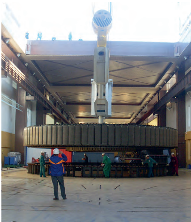
TG4-rotor pred uložením na mŕž bloku
