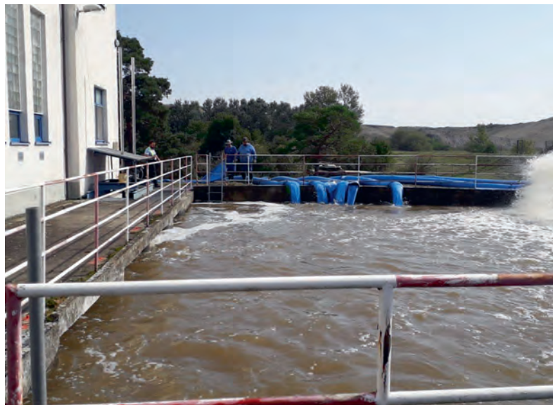
Prečerpávanie vôd na čerpacej stanici Zohor
