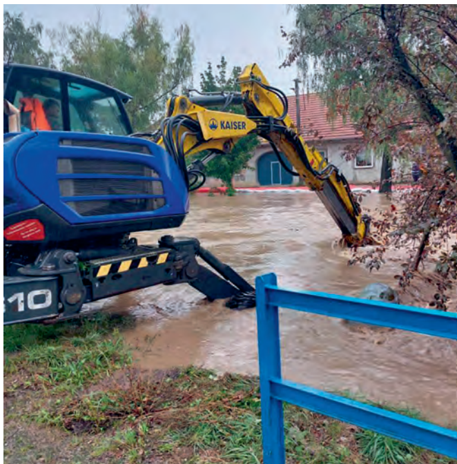
Povodňové zabezpečovacie práce na toku Teplica v obci Sobotište
