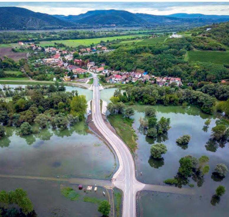
Septembrová povodňová situácia na Dunaji v podunajskej nížine
