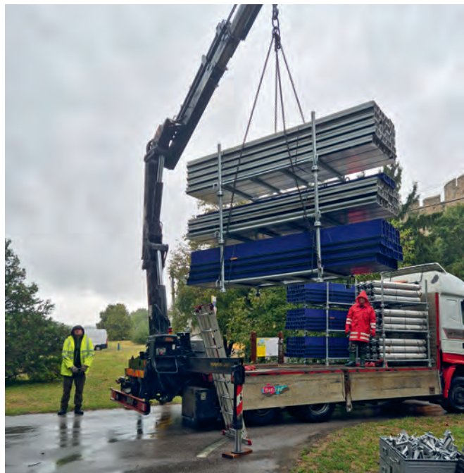
Dovoz a inštalácia mobilného hradenia na Devíne
