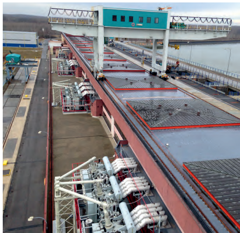
Portálový žeriav 275t pri manipulácii
