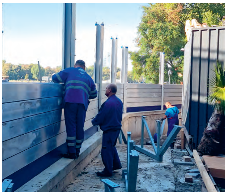
Demontáž mobilného hradenia pod starým mostom v Bratislave
