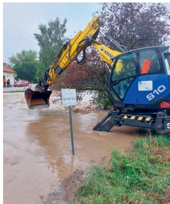
Povodňové zabezpečovacie práce realizované zamestnancami SVP
