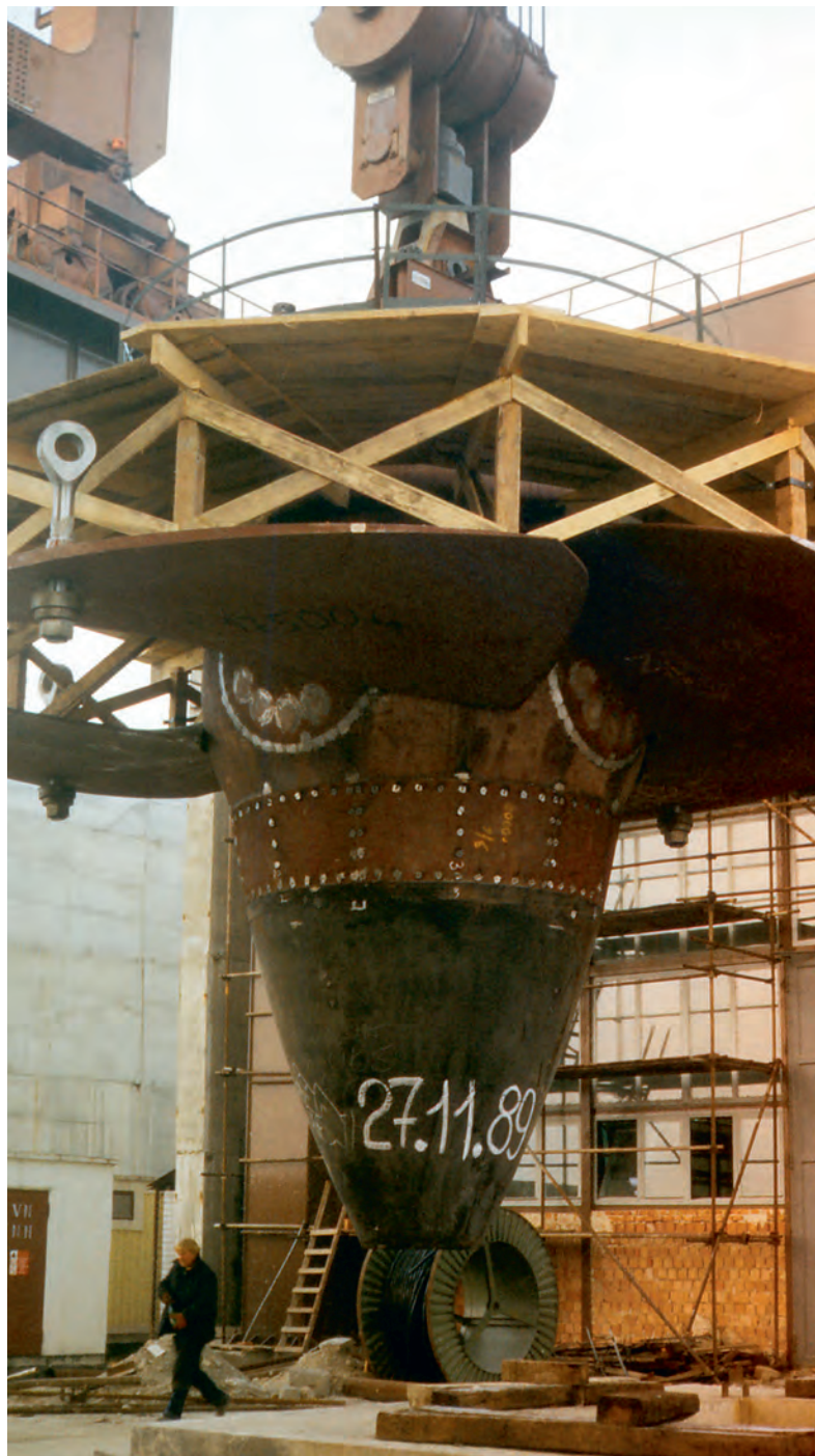
Inštalácia turbín pri výstavbe VE
