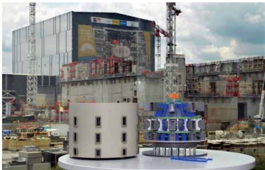
Stavebnice tokamaku před montážní halou – tedy na místě, kde bude skutečný reaktor tokamaku ITER. Vlevo je kryostat a vedle něho „zbytek tokamaku“. Pokud je „zbytek“ přikrytý kryostatem, je celý „zbytek“ v technickém vakuu kvůli omezení ohřívání supravodivého vinutí cívek magnetických polí.
