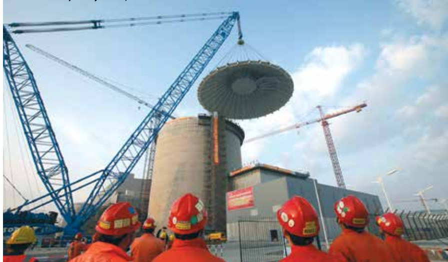
Instalace střešy kontejneru, Sanmen 1
