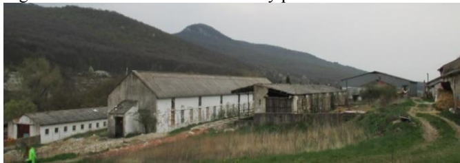
Obr. 10: Brownfieldy v Kostol'anoch pod Tríbečom Figure 10: Brownfields in Kostol'any pod Tríbečom
