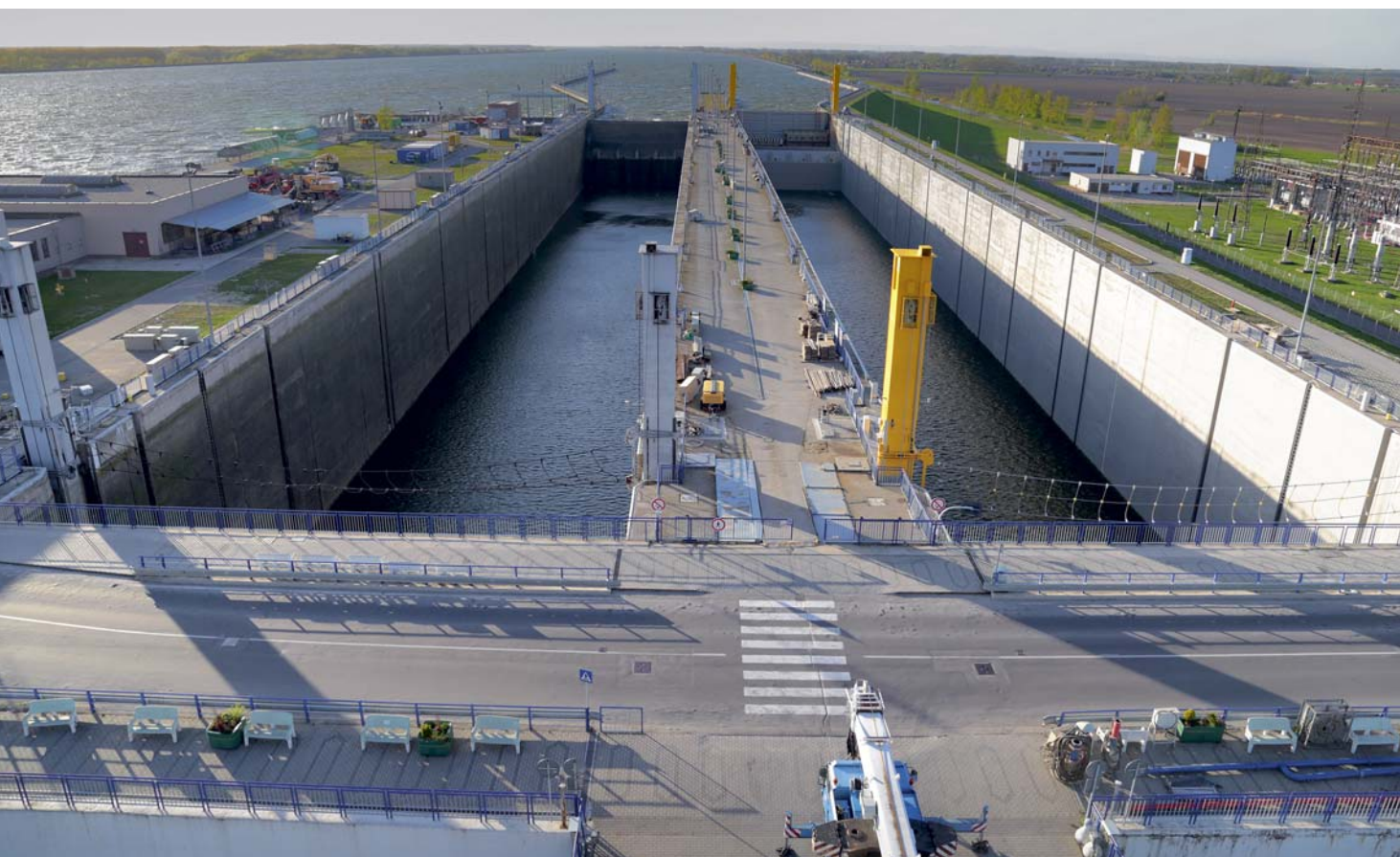
Pohľad zhora na plavebné komory Vodného diela Gabčíkovo, archív VV, š. p.
