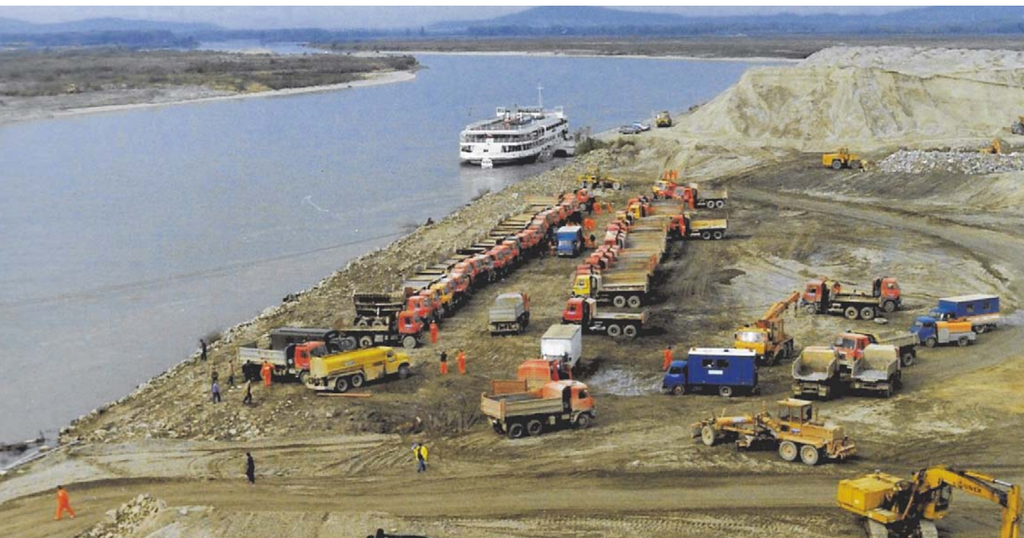
Provizórne premostenie, z ktorého sa uskutočnilo prehradenie Dunaja dňa 24. októbra 1992
