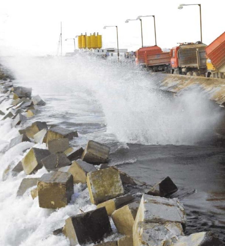
Prvé kamene s hmotnosťou približne 200 kg boli do Dunaja vyslané 24. októbra 1992 pomocou špeciálne upravených nákladných áut
