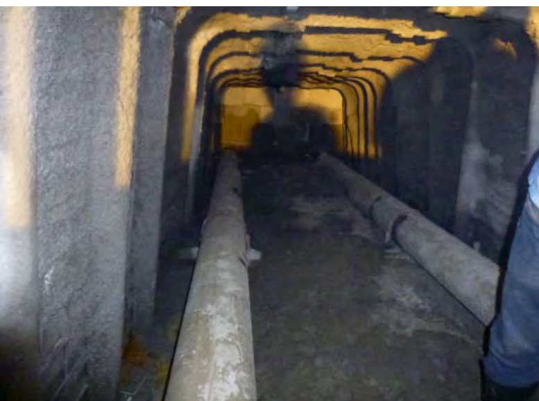
Obr. 1 Realizácia štôlne dnových výpustov
