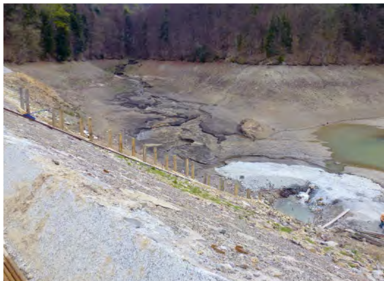
Obr. 2 Budovanie ovládania uzáverov dnových výpustov
