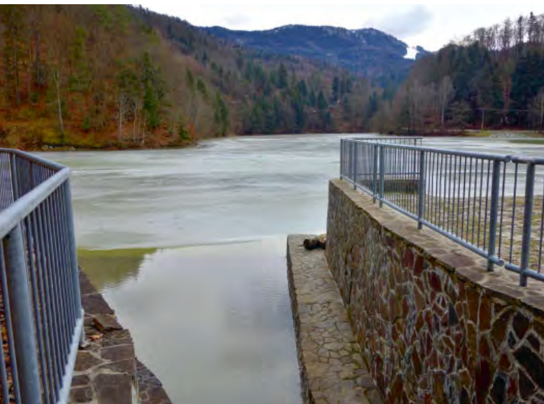
Obr. 4 Napustená vodná nádrž po rekonštrukcii a oprave
