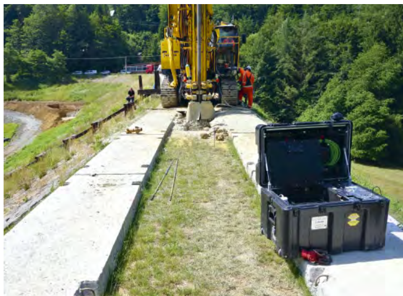
Obr. 3 Realizácia podzemnej tesniacej steny
