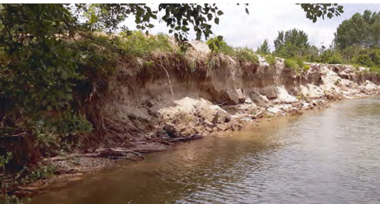
Kolónia brehule hnedej v poslednom – piatom obnovenom úseku
