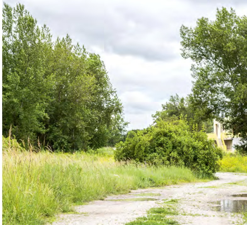
Pohľad na náletové dreviny. V pozadí malá vodná elektrárň (MVE TB-2)
