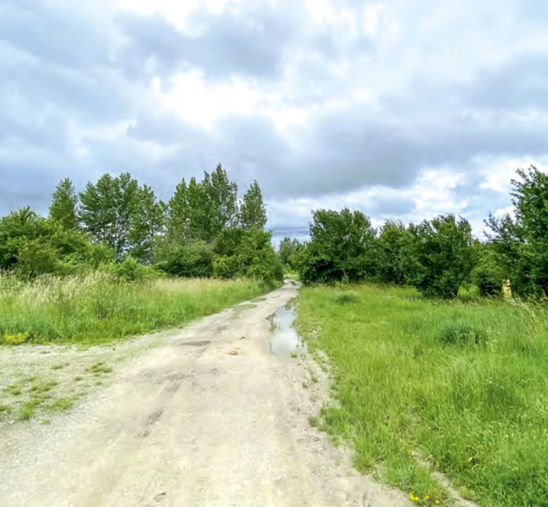
Jedna z účelových nespevnených komunikácií určených na údržbu vykonávané správcom toku (SVP)
