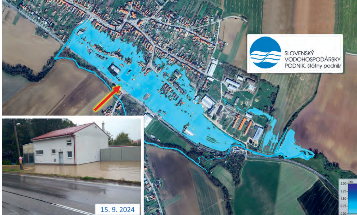
Obr. č. 7 Štátna cesta č. 51 v obci Radošovce počas povodne – september 2024 (zdroj orthofoto: GKÚ Bratislava, ostatné archív SVP, š. p.)
