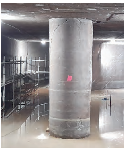
Obr. č. 13 Opancierovanie najviac namáhaných častí medzistienok kanálového systému
