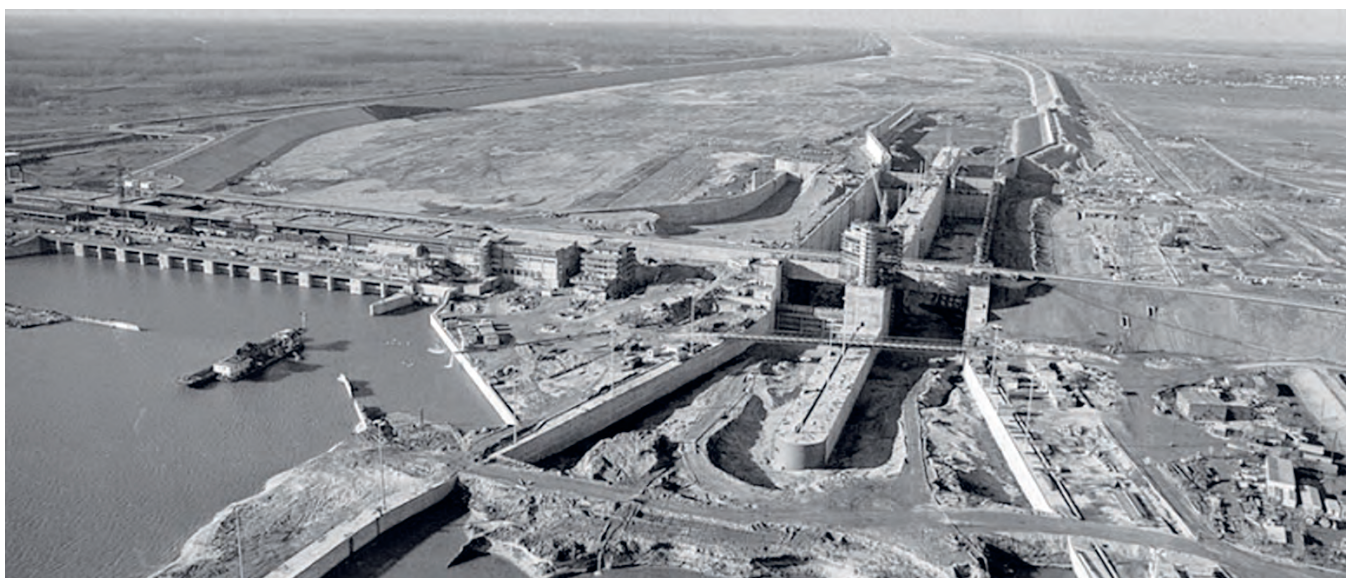
Obr. č. 19 Vodné dielo Gabčíkovo – výstavba 1990
