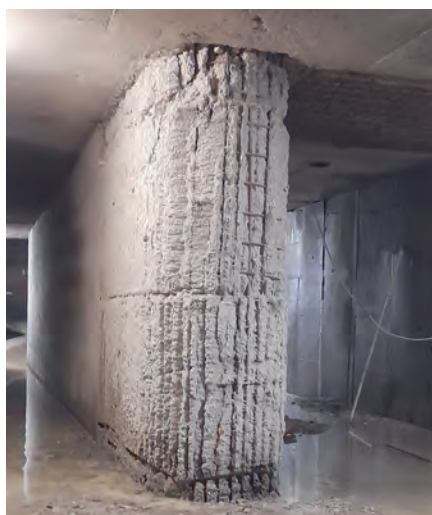
Obr. č. 13 Opancierovanie najviac namáhaných častí medzistienok kanálového systému
