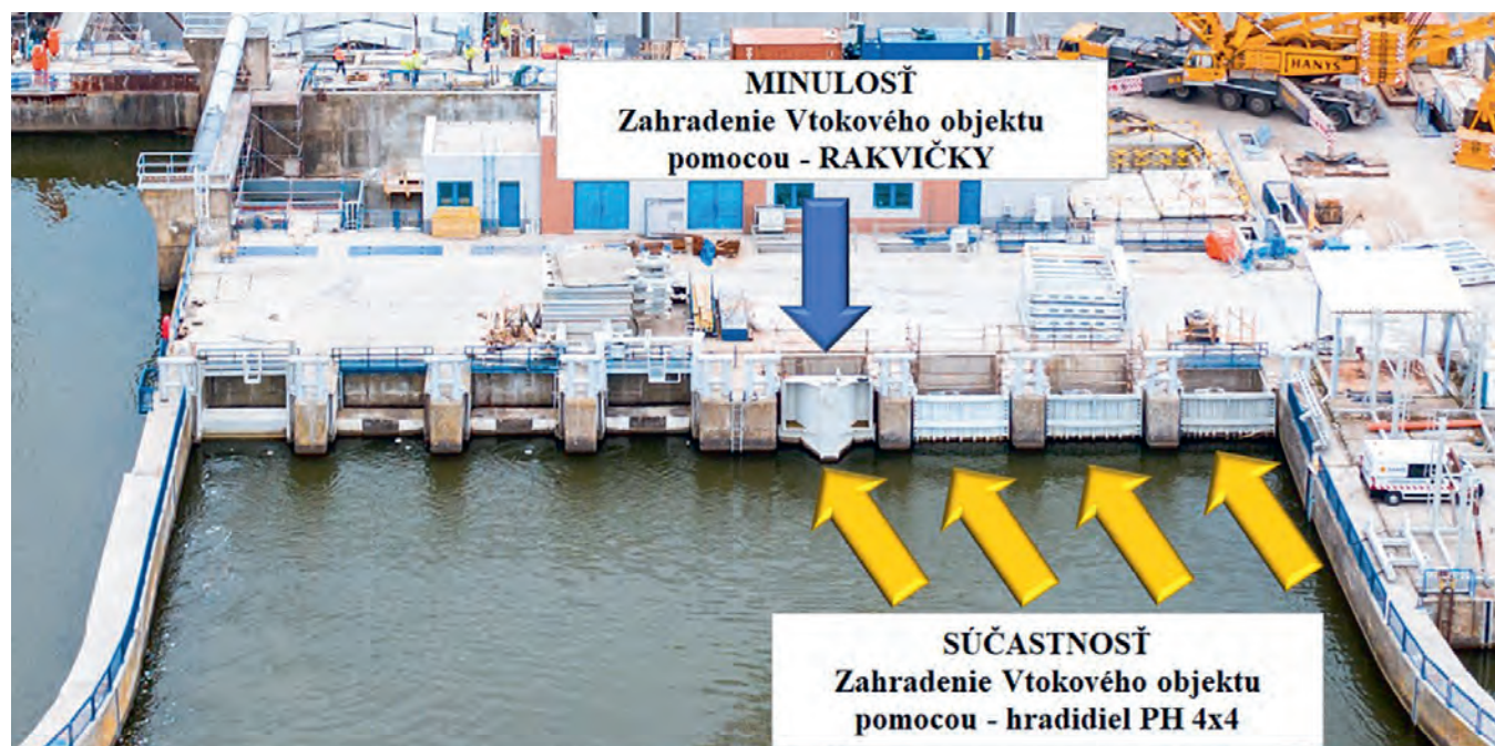
Obr. č. 7 Provizórne hradenia vtokového objektu
