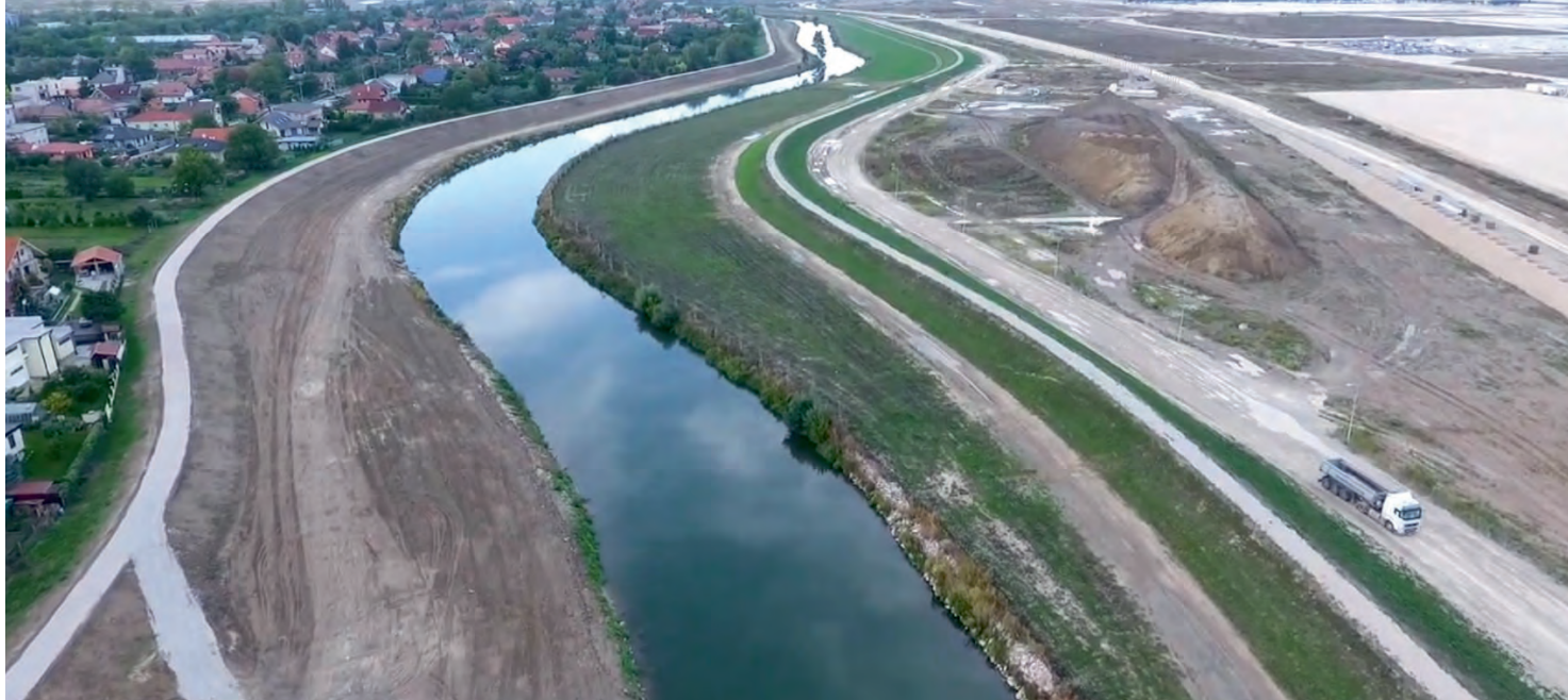
Obr. č. 4 Úprava beriem a ochranných hrádzí na rieke Nitra pri priemyselnom areáli Jaguár – Land Rover (zdroj: archív SVP, š. p.)
