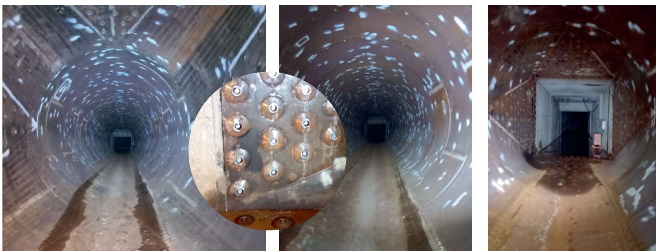
Obr. č. 16 Pohľad do ocelevej rúry (biele značky sú stopy po realizovaných skúškach ocelevej konštrukcie)
