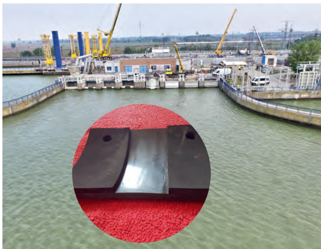
Obr. č. 14 Utesnenie dilatácií vtokového objektu a príľahlej časti spojovacieho múru
