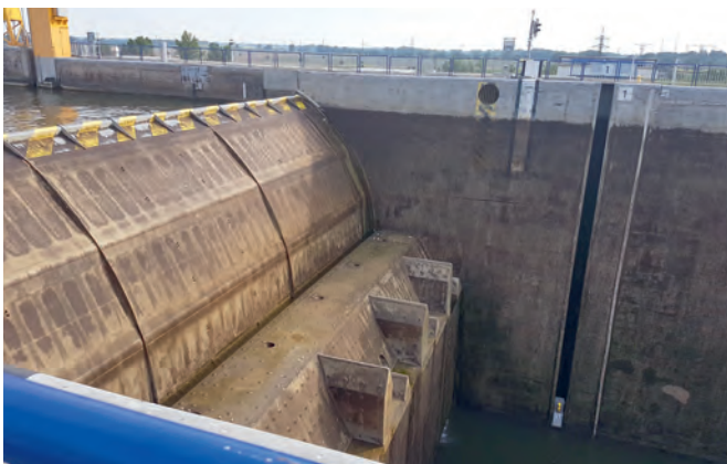
Obr. č. 4 Porovnanie pôvodnej a súčasnej konštrukcie hlavných horných vrát PLK – G
