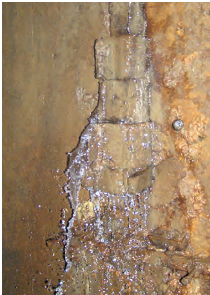
Obr. č. 12 Pôvodná lokálna sanácia netesnej dilatácie
