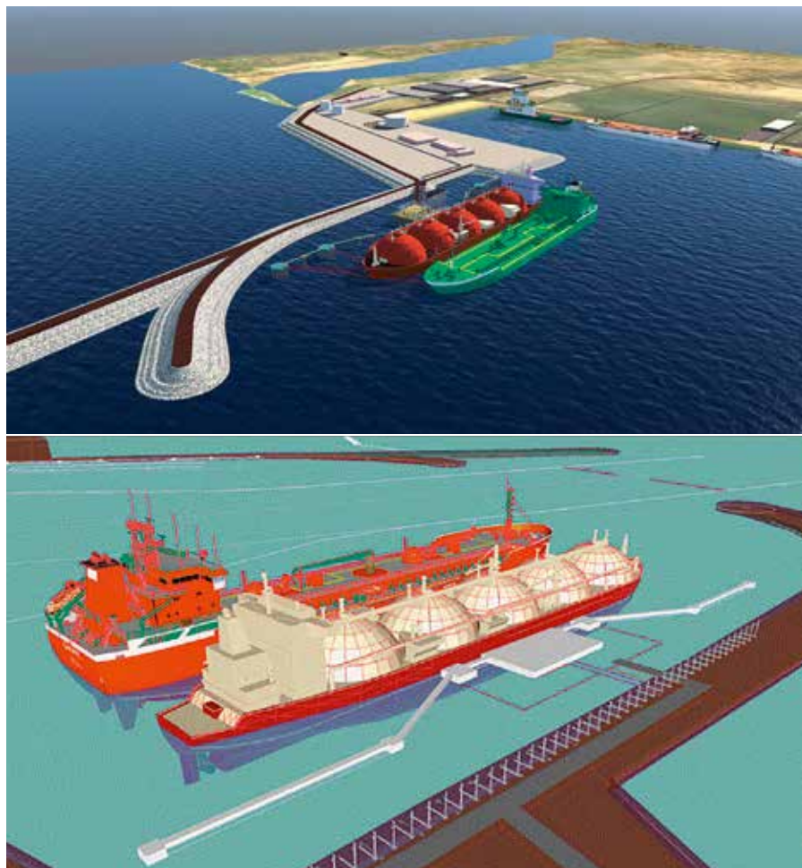
Plynárenská a logistická společnost AG&P buduje terminál na dodávky LNG v přístavu Karaikal v Puducherry a připravuje tak cestu k většímu uplatnění zemního plynu jako primárního paliva v jižní Indii. Očekává se, že zařízení Karaikal zahájí komerční provoz do 4. čtvrtletí 2021.
