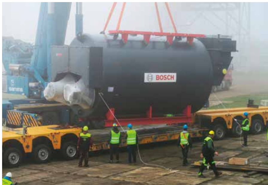
Horkovodní kotel Bosch o výkonu 26 MWt už je v budoucí plynové kotelně Elektrárny Pruněřov II na svém místě Zdroj: ČEZ
