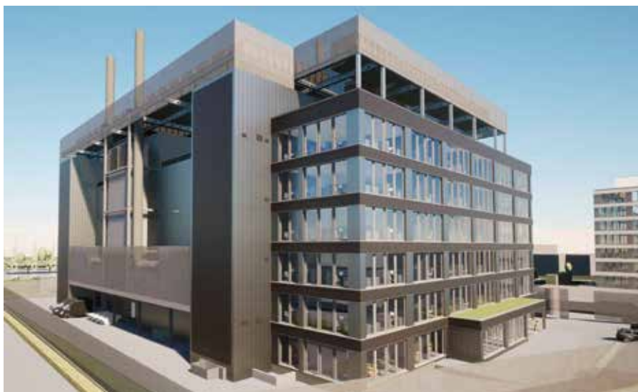
V Curychu zahájili výstavbu čtvrtého datového centra v Metro Campus Zurich West. Uvedení tohoto datacentra o rozloze 5500 m 2 a kapacitě 12 MW do provozu je naplánováno na rok 2026. Elektřina pro provoz by měla pocházet z vlastní, klimaticky neutrální výroby, datacentrum bude navíc vybaveno odvodem odpadního tepla pro místní využití.
