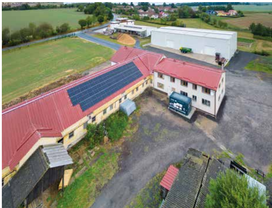
Fotovoltaická elektrárna a bateriové úložiště: dokonalé duo
