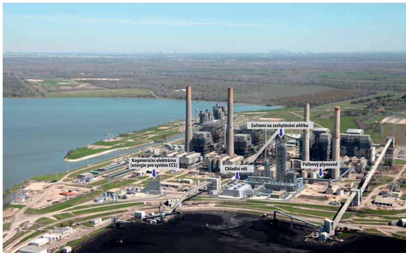
Petra Nova byla první velkou průmyslovou instalací technologie CCS.
